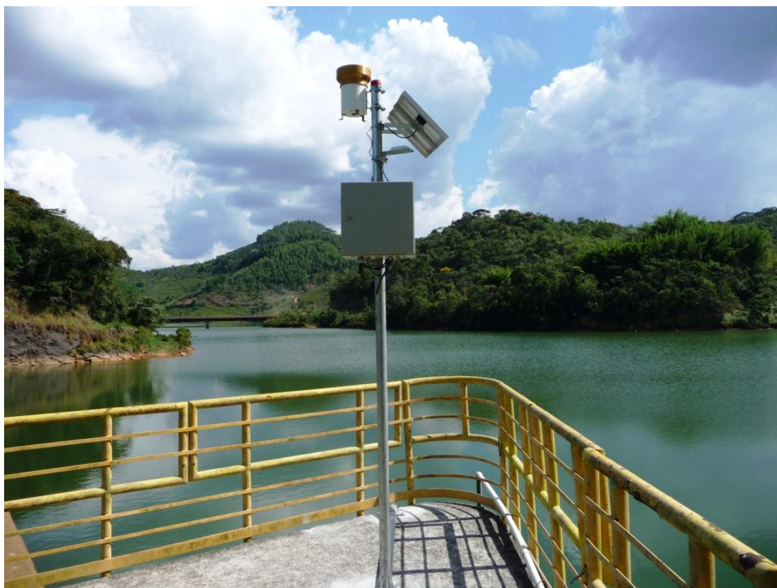
Figura 3-8 - Estação Hidrométrica Fumaça Barramento
