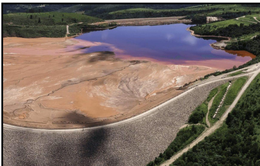
Figura 1: Barragem de rejeito de mineração
