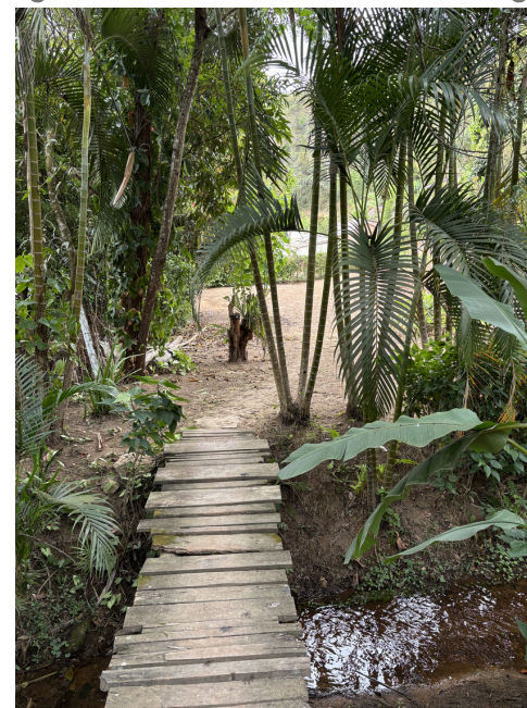
Figura 33 – Passarela sob córrego.
