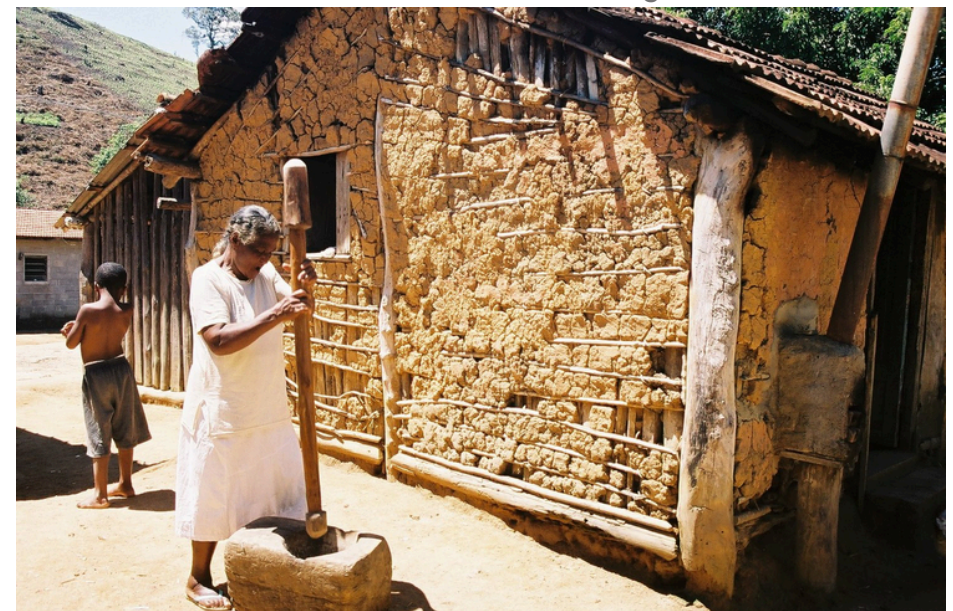
Figura 2 - Exemplo de uma casa quilombola construída com materiais naturais - Quilombo Cangume, Itaóca.
