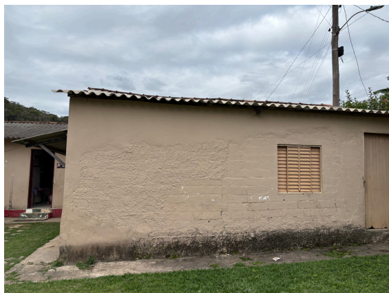
Figura 28 - Parede em bloco de concreto.
