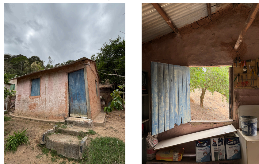
Figura 17 – Casa de pau a pique localizada na Associação Esperanza Brasil
