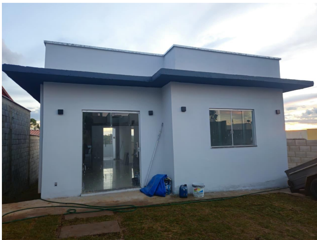
Figura 12 - Vista da obra concluída, com a casa, o passeio e o aterro (maio de 2026)
