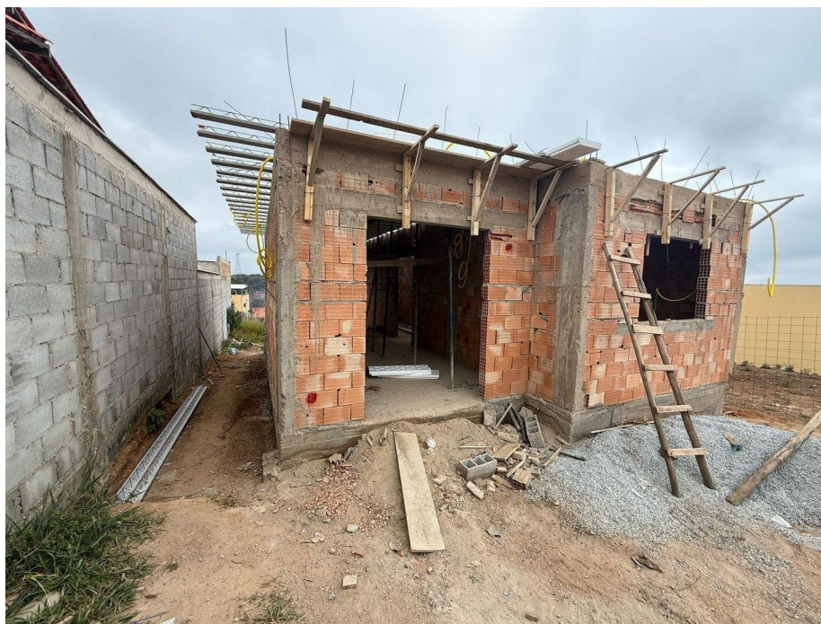
Figura 8 - Execução da alvenaria e da estrutura da cobertura (junho de 2025)
