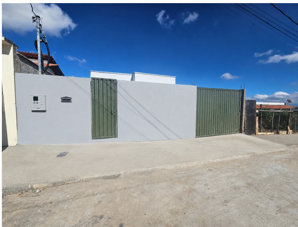
Figura 11 - Muro, portões e passeio frontal concluídos (maio de 2026)
