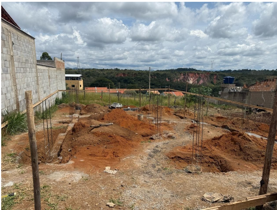
Figura 7 - Locação da obra e escavação das sapatas da fundação (março de 2025)
