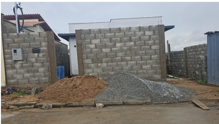
Figura 10 - Execução do muro da frente externa (março de 2026)
