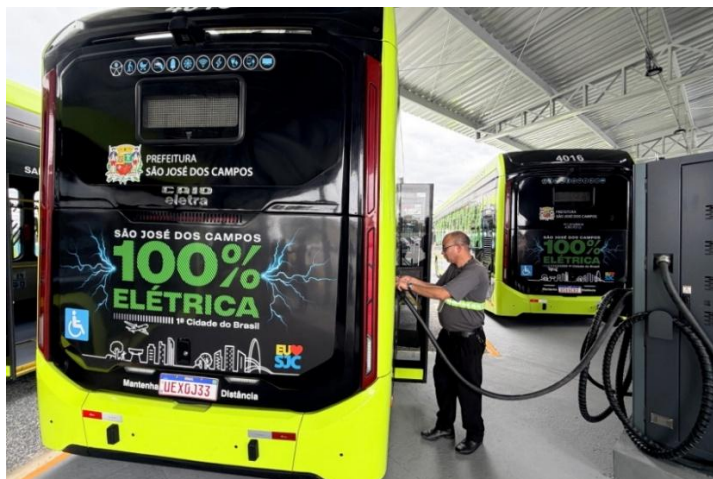
Figura 13 – Imagem representativa de estação de recarga de ônibus elétricos em São José dos Campos
