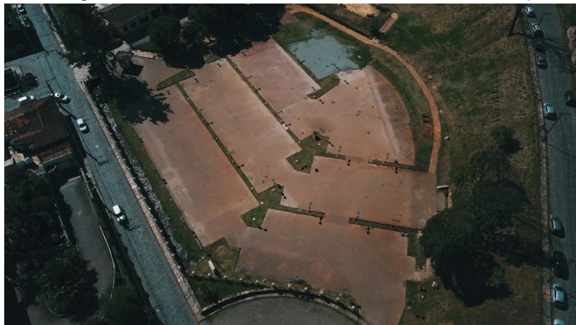
Figura 08 -Imagem Área do Estacionamento do Centro de Artes e Convenções da Ufop
