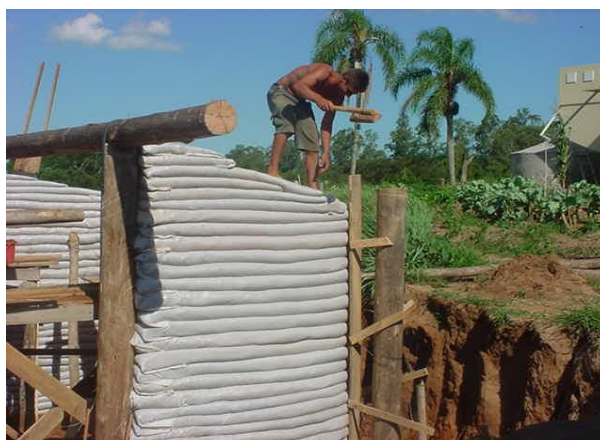
Figura 2 – Construção de Superadobe
