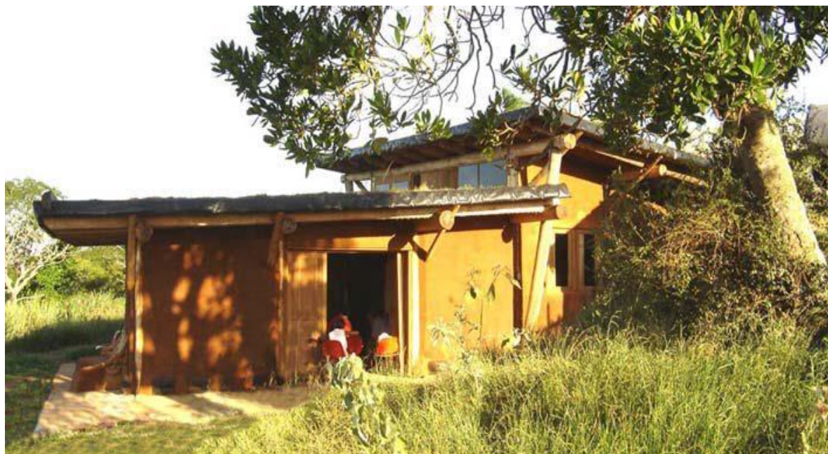
Figura 3 – Oficina do Assentado - Obra Concluída
