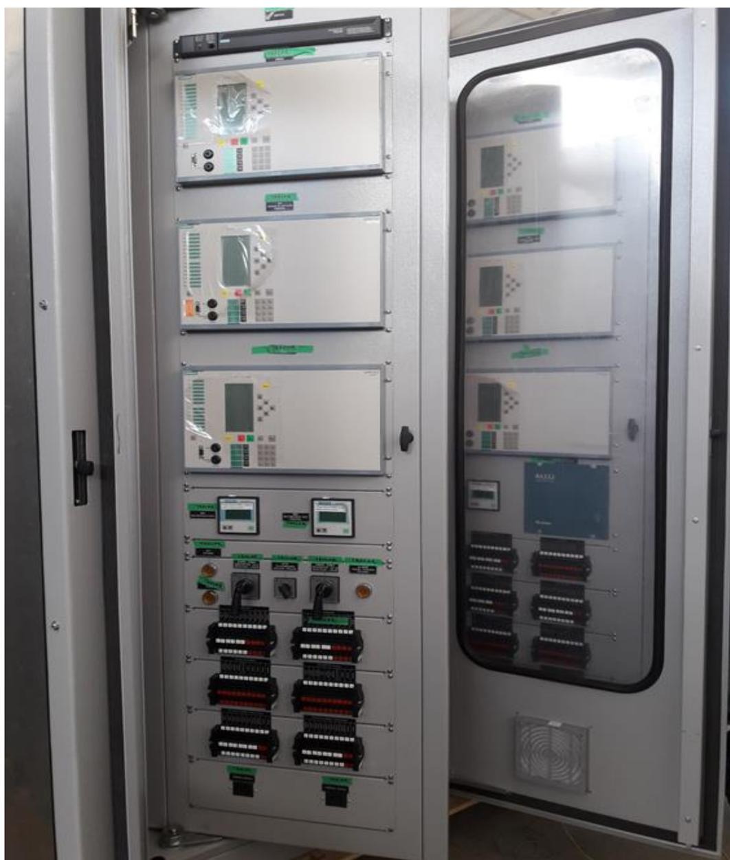
**Figura 11 - Painel do Transformador 230/69K**
