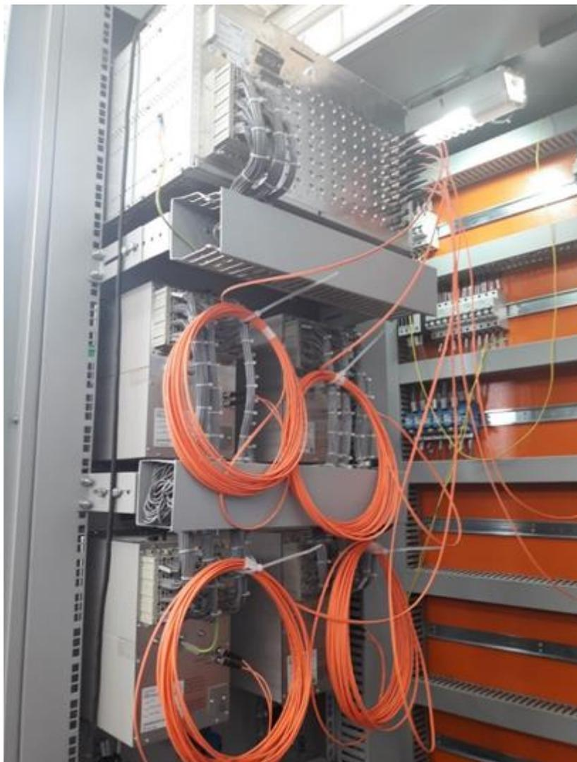
**Figura 12 – Interior do painel diferencial de barras 69kV**
