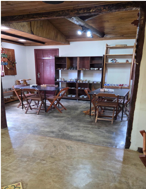
Figura 1 - Piso da área de atendimento feito em cimento queimado
