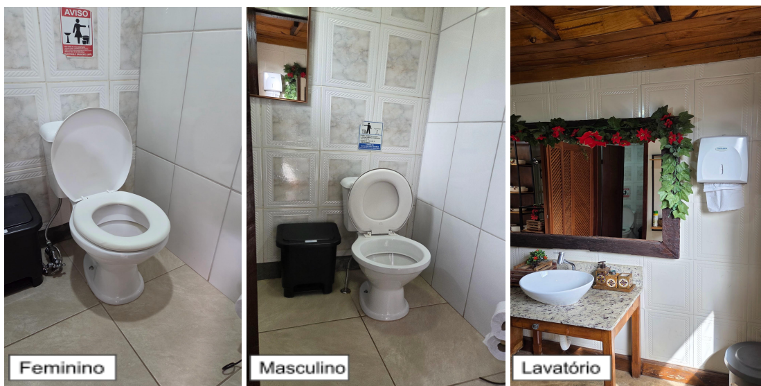
Figura 3 - Pisos e azulejos dos sanitários dos clientes
