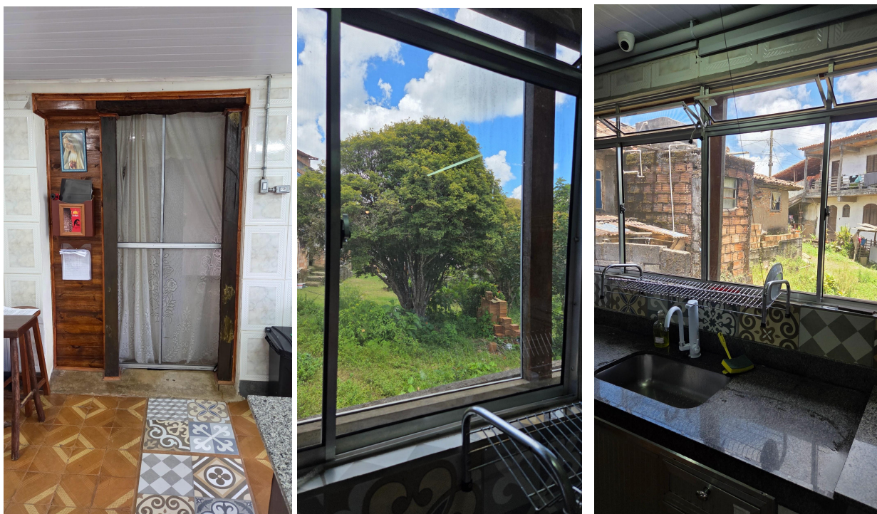
Figura 5 - Telas removíveis de proteção em alumínio na porta e janelas da área de produção
