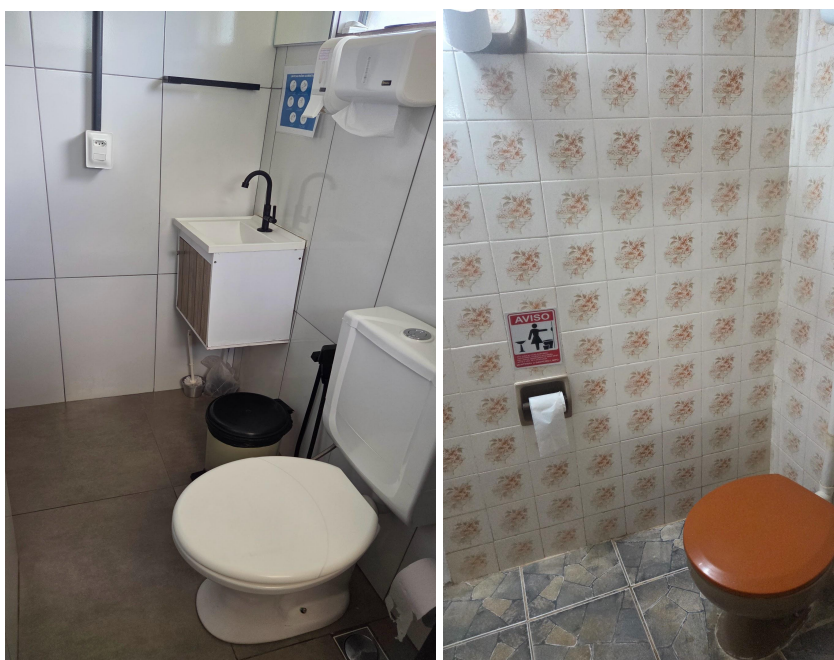
Figura 4 - Pisos e azulejos dos sanitários dos freelancers
