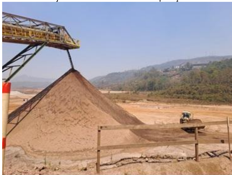
Figura 3. 4 - Pilha de rejeito arenoso filtrado em operação na Samarco, Mariana
