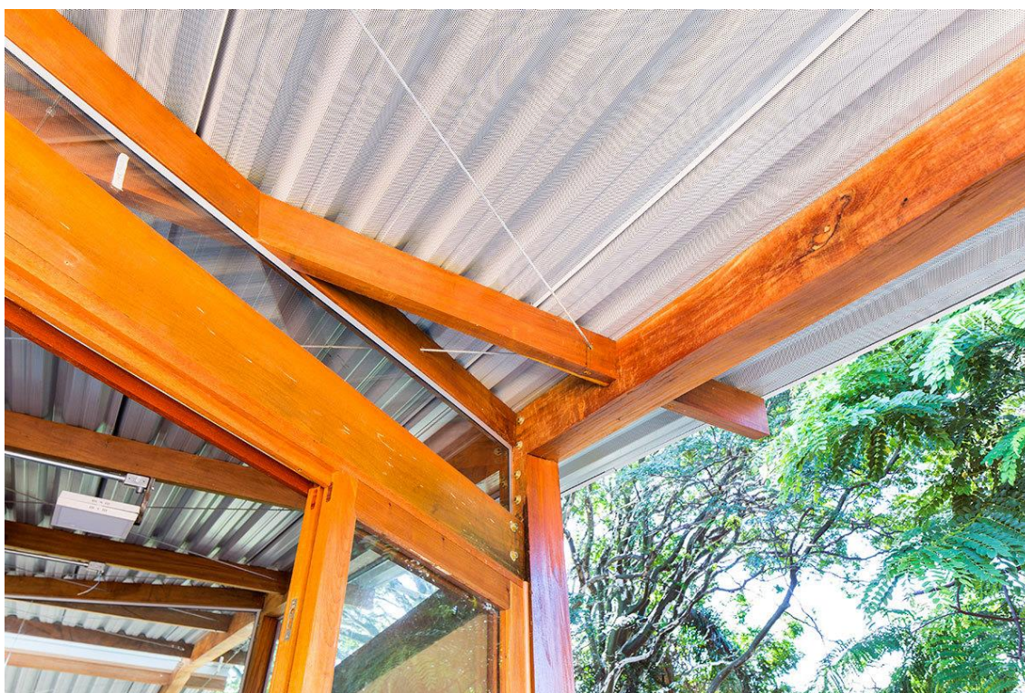
Figura 7 - Estrutura de madeira e cobertura
