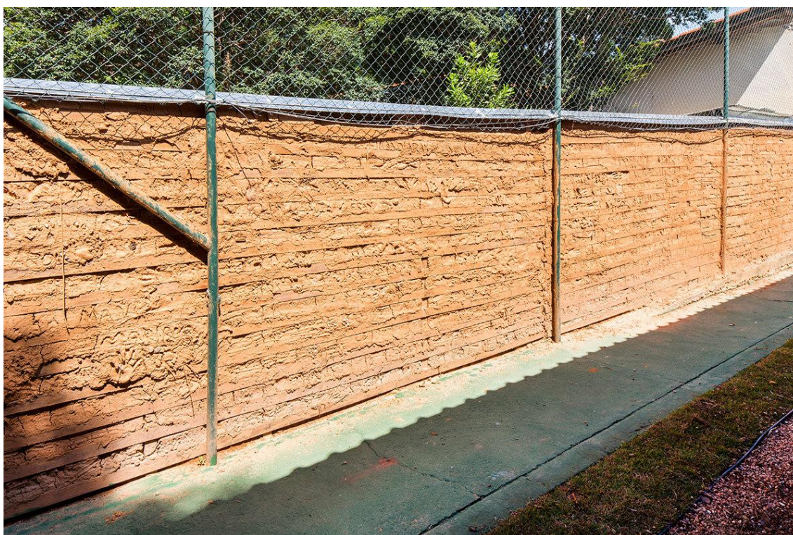
Figura 10 - Muro executado pelos pais e alunos utilizando a técnica da Taipa
