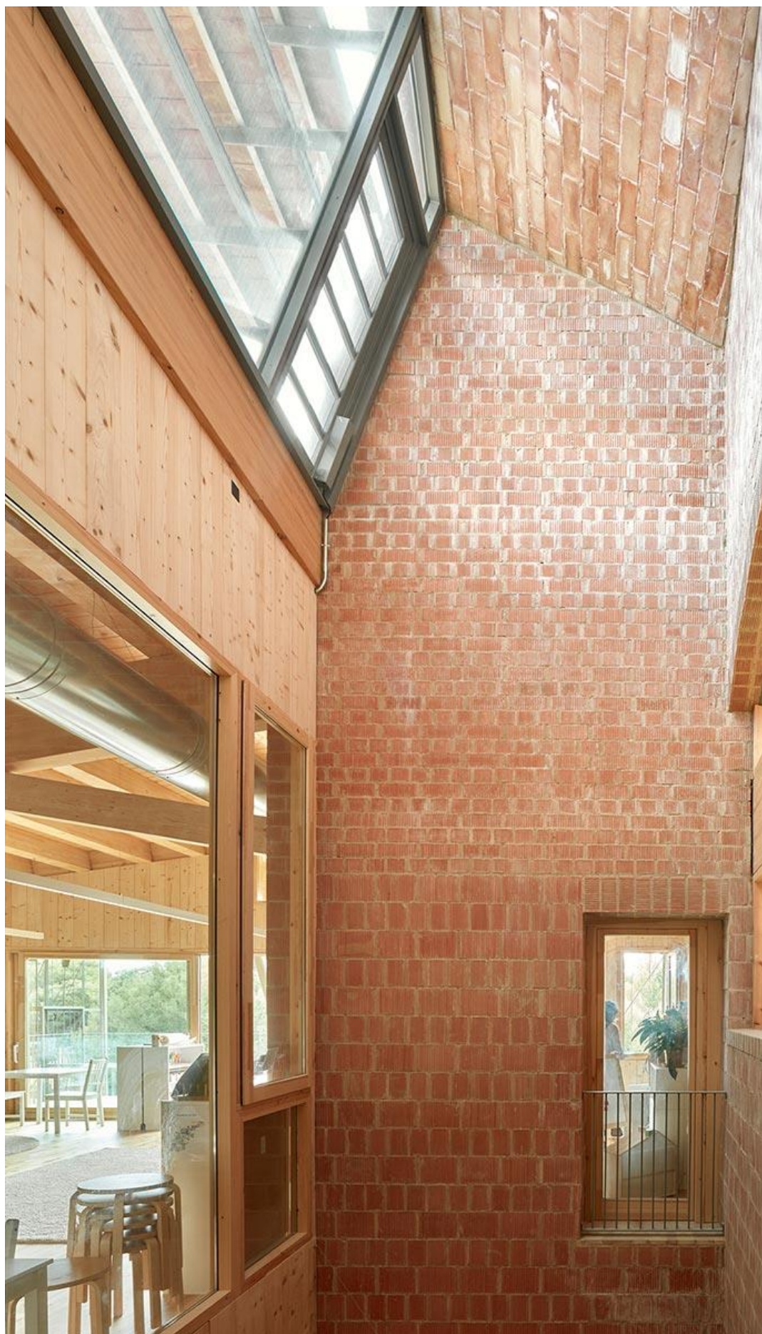
Figura 4 - Coletor solar da escola
