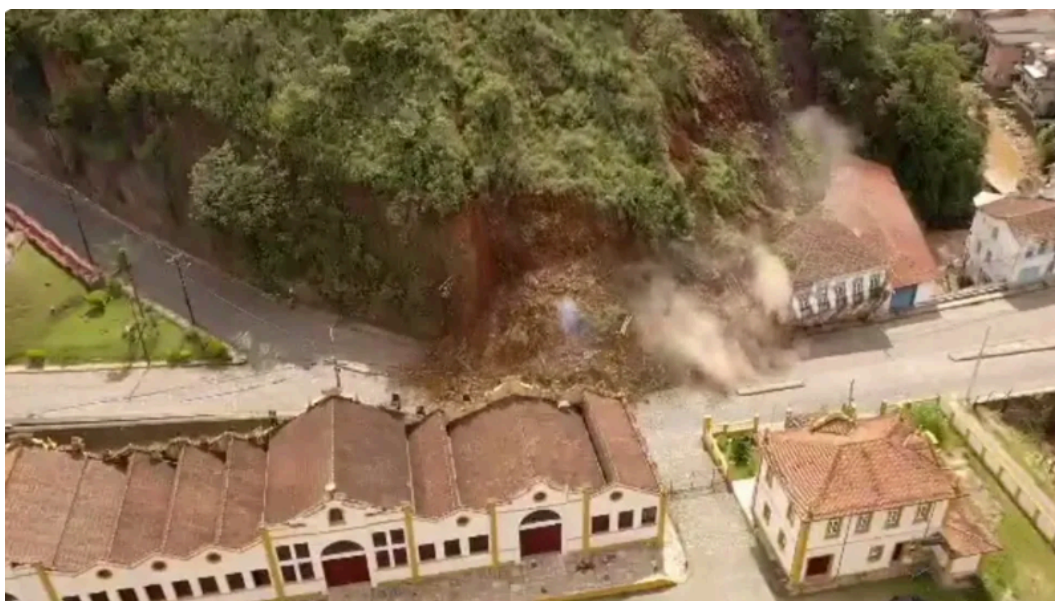
Figura 35 - Vista do deslizamento no Morro da Forca.
