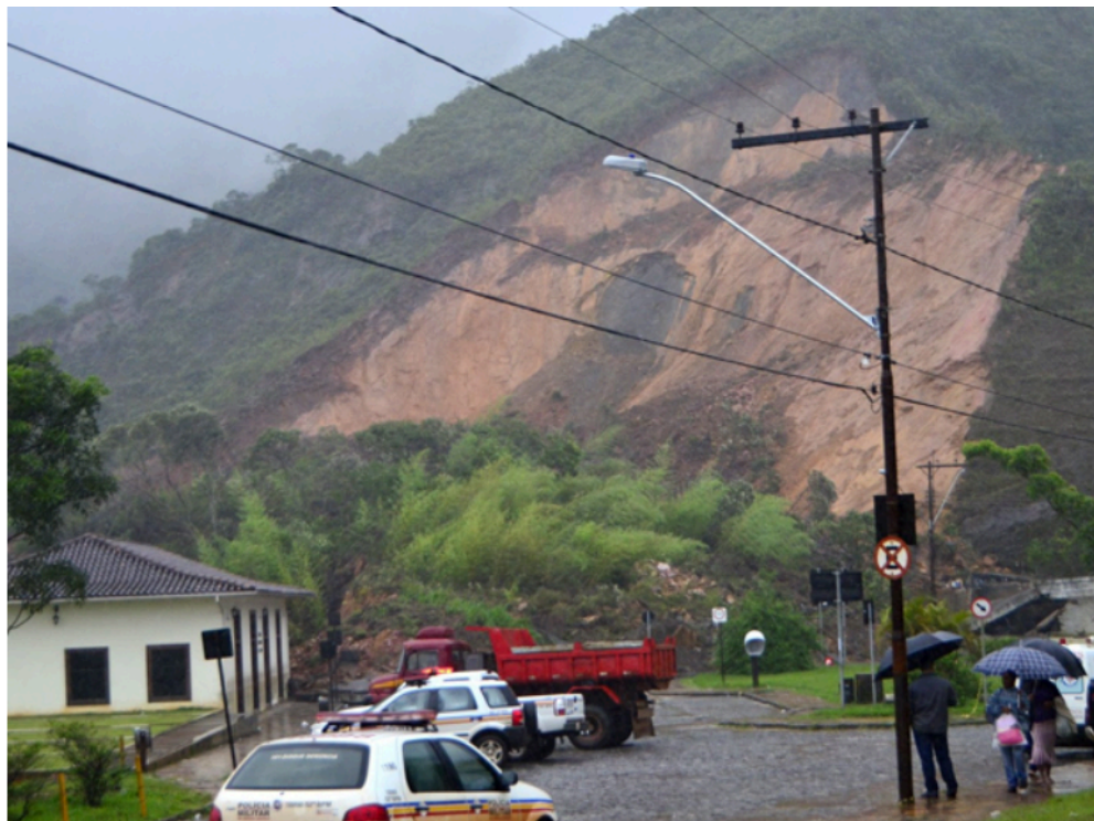
Figura 34 - Vista do deslizamento sobre a rodoviária em 2012.
