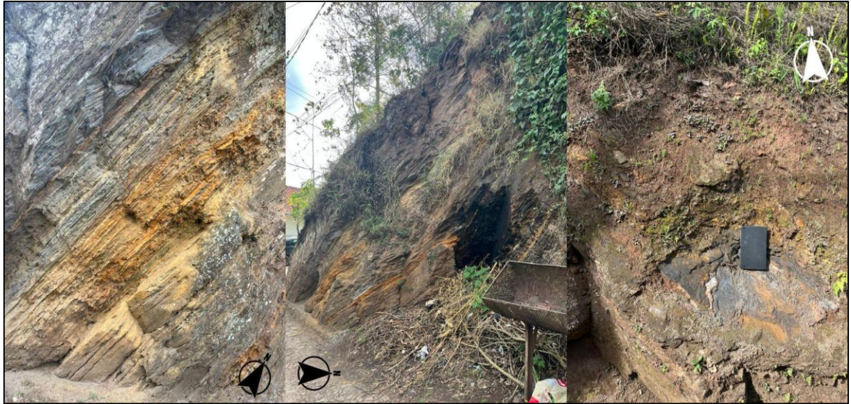
Figura 6.15- Talude com a rocha mergulhando aproximadamente ( 210^{\circ}/35^{\circ} ) na Rua Valentim Policarpo do Ponto 7, mostrando cavidade no local e níveis hematíticos da Formação Cauê.
