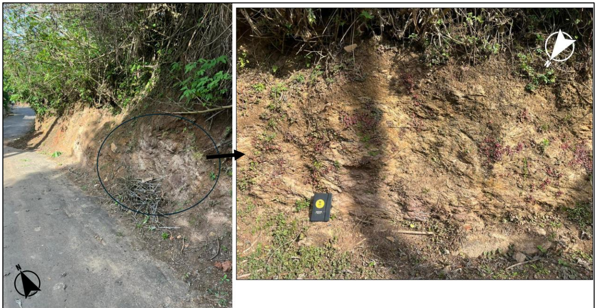
Figura 6.8 – Ponto P1, exposição de filito da Formação Cercadinho, com grau de alteração variando entre W3 e W4 e estrutura da rocha parcialmente preservada.
