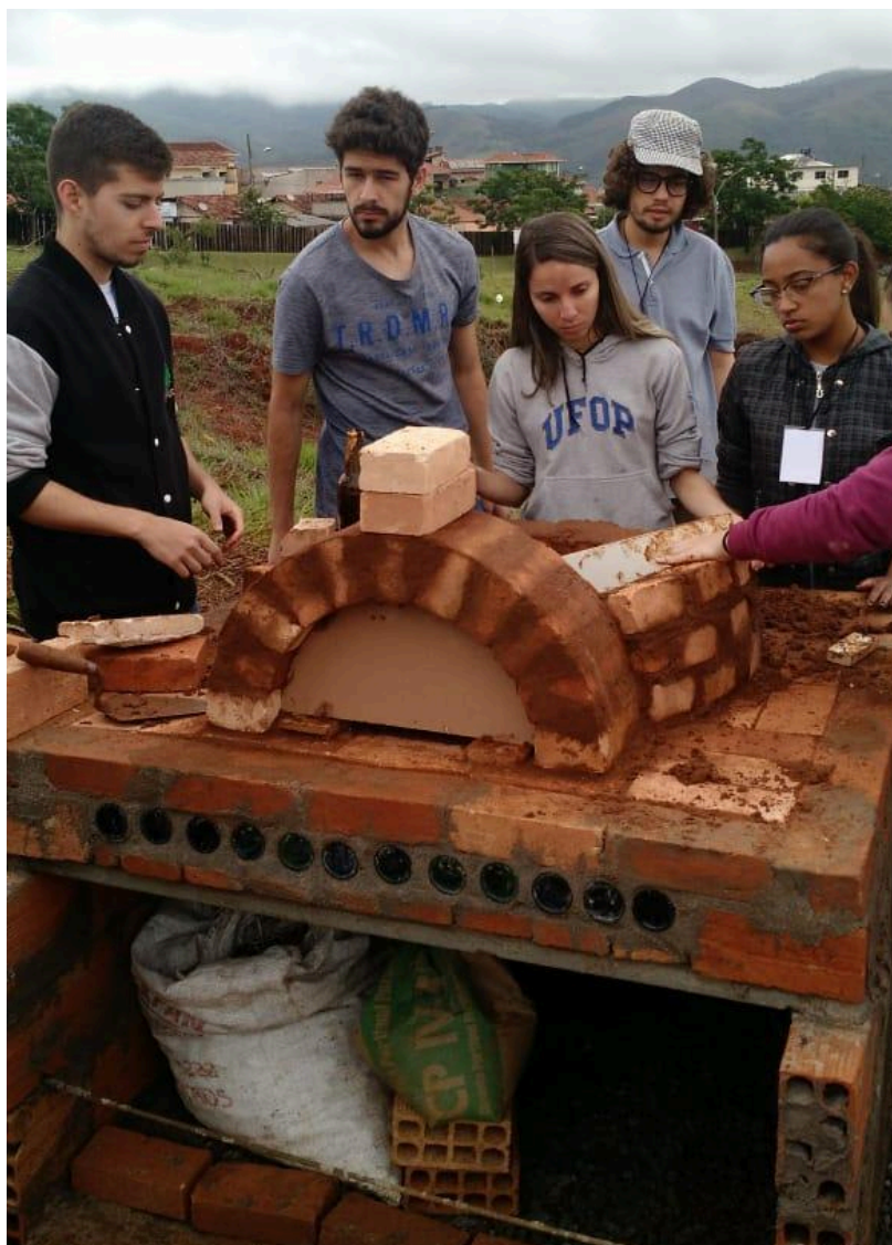
Figura 22: Etapas Iniciais da Construção do Forno de Pizza nas Imediações da Escola de Minas
