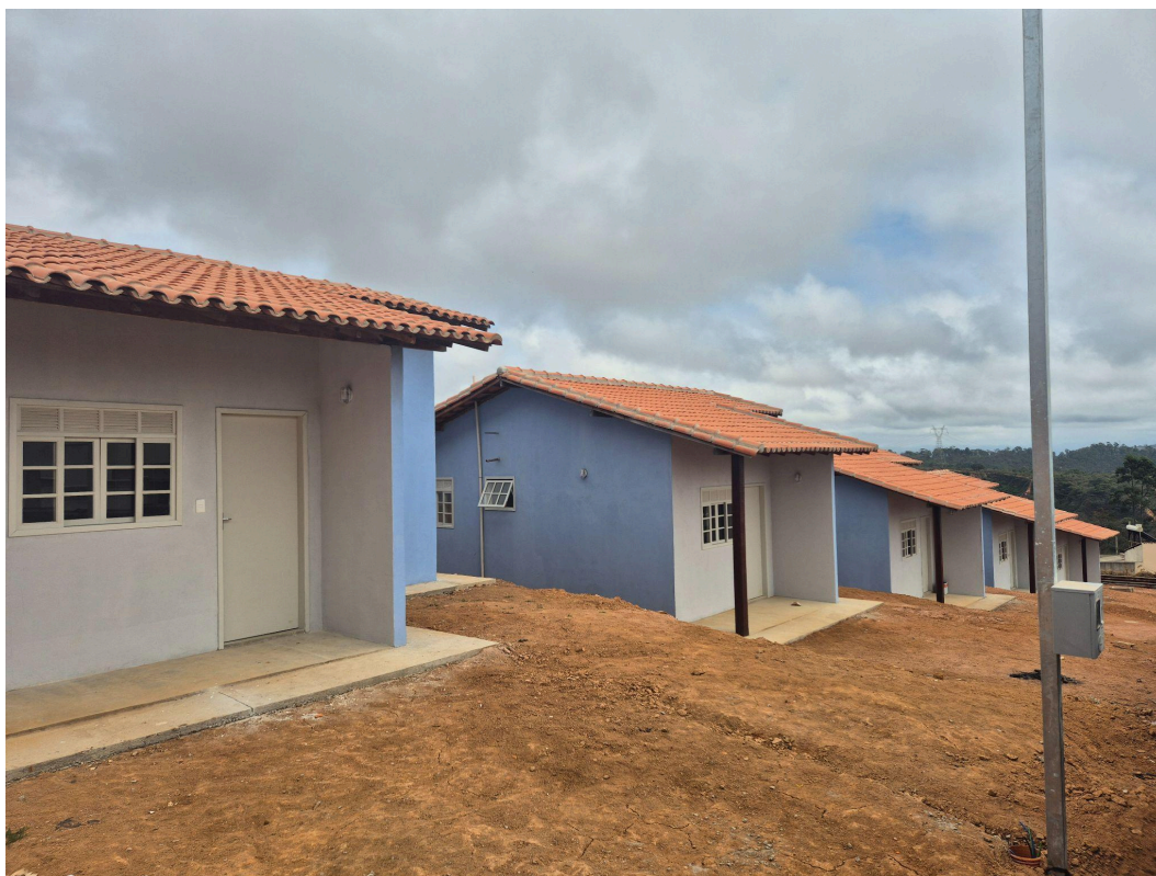
Figura 03 — Padronização habitacional no Residencial Vila Alegre, Ouro Preto (MG).
