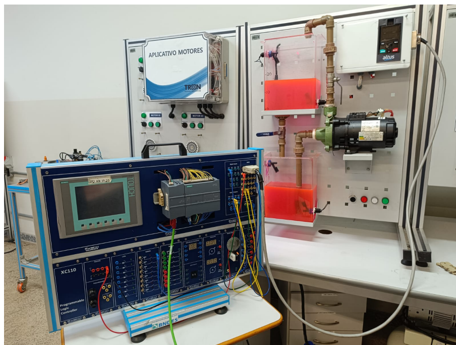
Figura 23 – Conexão do kit XC110 com a planta de controle de nível. Fonte: Acervo do autor (2026).
