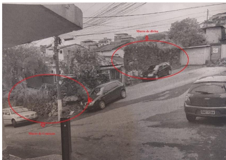
Figura 5 - Muro de mundéu, sendo utilizado como muro de contenção e de divisa.
