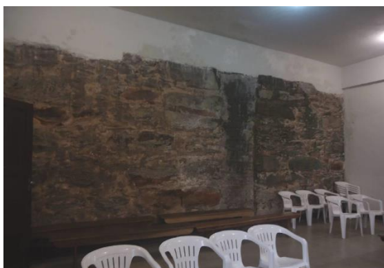
Figura 6 - Muro de mundéu utilizado preservado no salão paroquial
