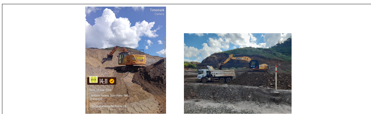
Figura 15 – Operação de retaludamento e carregamento de bloco de mina com escavadeira hidráulica. Fonte: Elaborado pelo autor.
