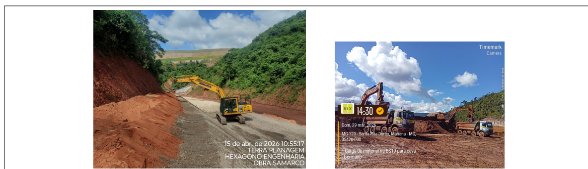
Figura 12 – Acabamento em alto declive e carregamento de material fino com escavadeira hidráulica. Fonte: Elaborado pelo autor.
