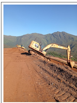
Figura 14 – Operação de escavadeira hidráulica em rampa. Fonte: Elaborado pelo autor.
