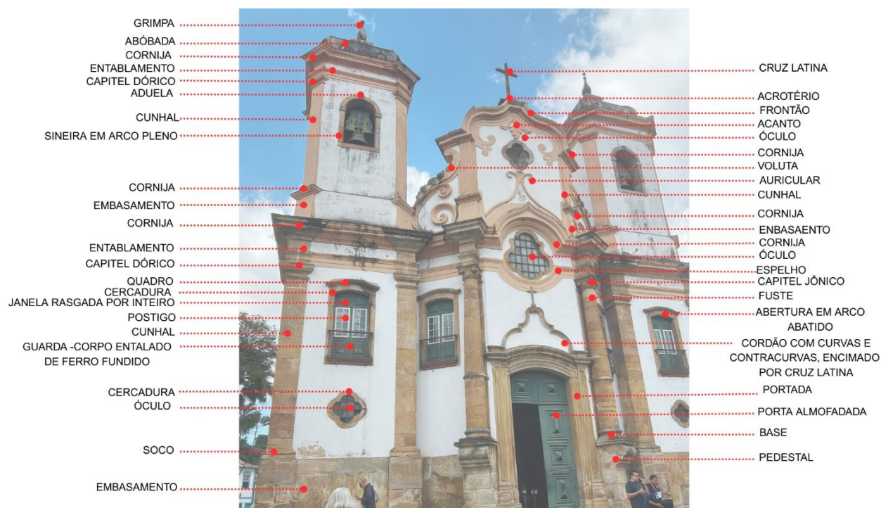
Figura 38. Elementos da atual fachada principal da Matriz do Pilar.
