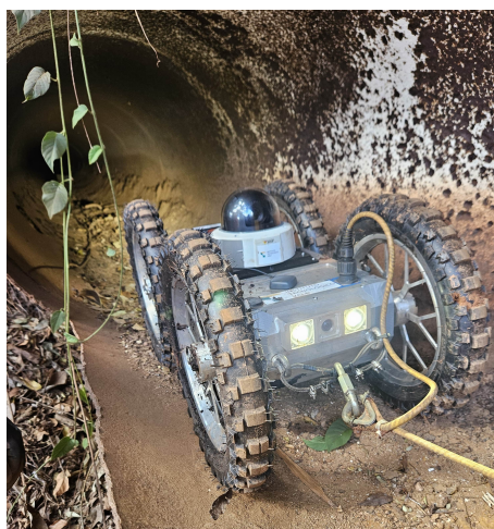
Figura 3 – EspeleoRobô fazendo inspeção em uma tubulação.
