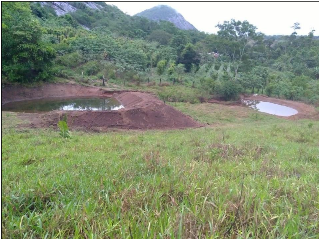
Figura 8 - Sistema de barraginhas implementado para contenção de sedimentos e recarga hídrica no Espírito Santo
