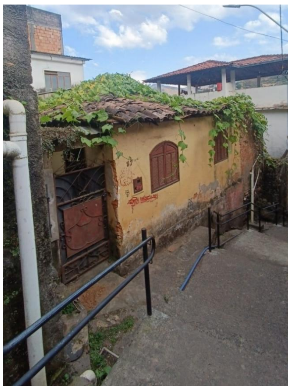
Figura 7 – Vista da fachada da edificação.
