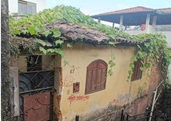
Figura 28 – Vista da fachada da edificação. Fonte: Autoria própria (2025).
