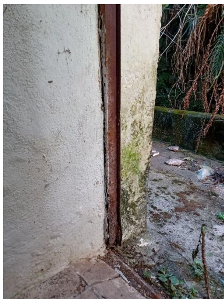
Figura 24 – Esquadria da porta de entrada da Casa 02.
