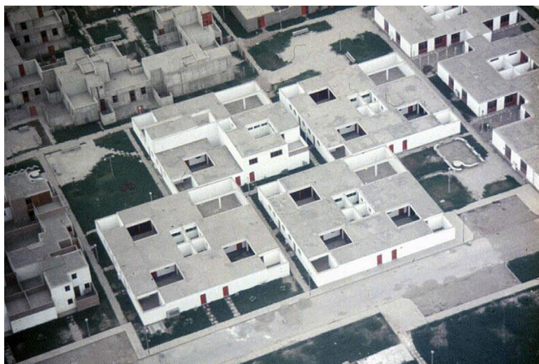
Figura 2- PREVI (Proyecto Experimental de Vivienda), Lima, Peru. Conjunto habitacional experimental com crescimento progressivo das unidades.
