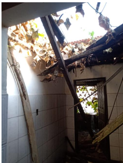
Figura 20 – Telhado da Casa 01. Fonte: Autoria própria (2025).
