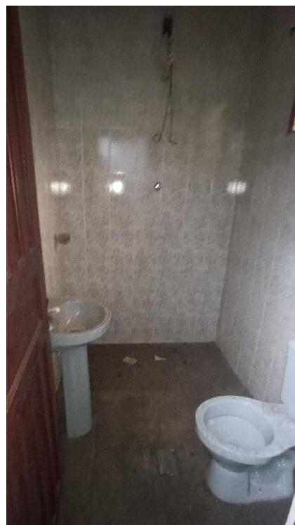
Figura 27 – Banheiro da Casa 02. Fonte: Autoria própria (2025).
