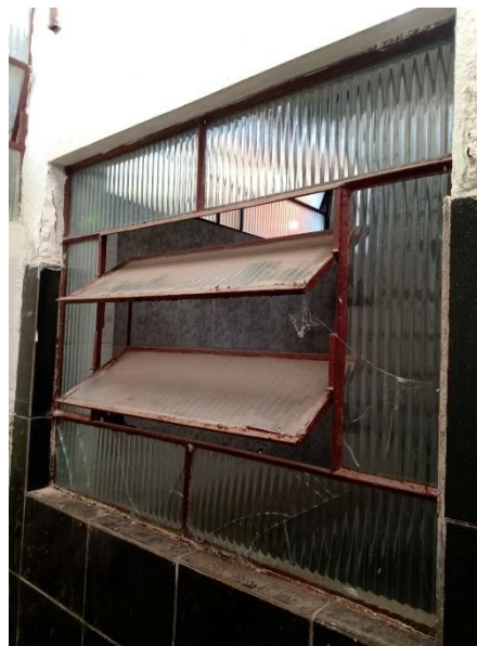
Figura 25 - Esquadria da janela da cozinha da Casa 02.
