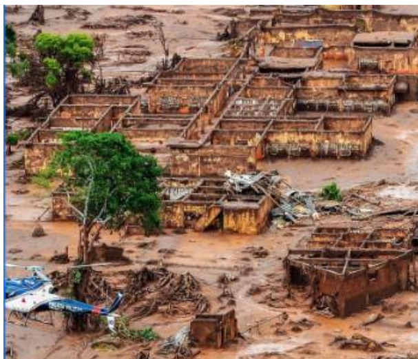
Figura 4 – Distrito de Bento Rodrigues após o rompimento
