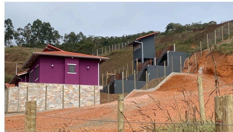
Figura 25. Topografia de um dos terrenos do reassentamento de Paracatu de Baixo. Fonte: Acervo da autora (2023).
