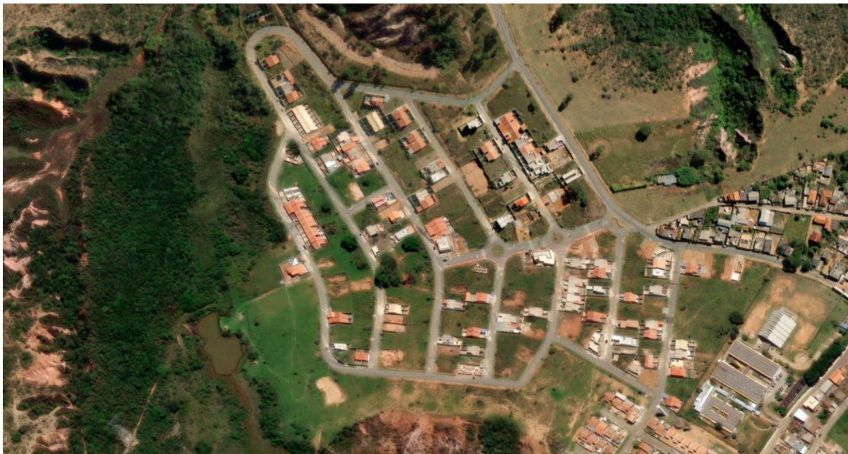
Imagem 30: Foto de satélite do loteamento Parque da Lagoa, onde é possível ver diversas edificações geminadas. Fonte: WebGis de Ouro Preto
