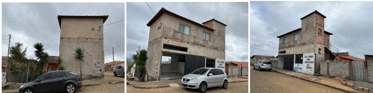
Imagens 59 a 61: Exemplo de registro fotográfico para levantamento de modificações. Fonte: Autoria própria.
