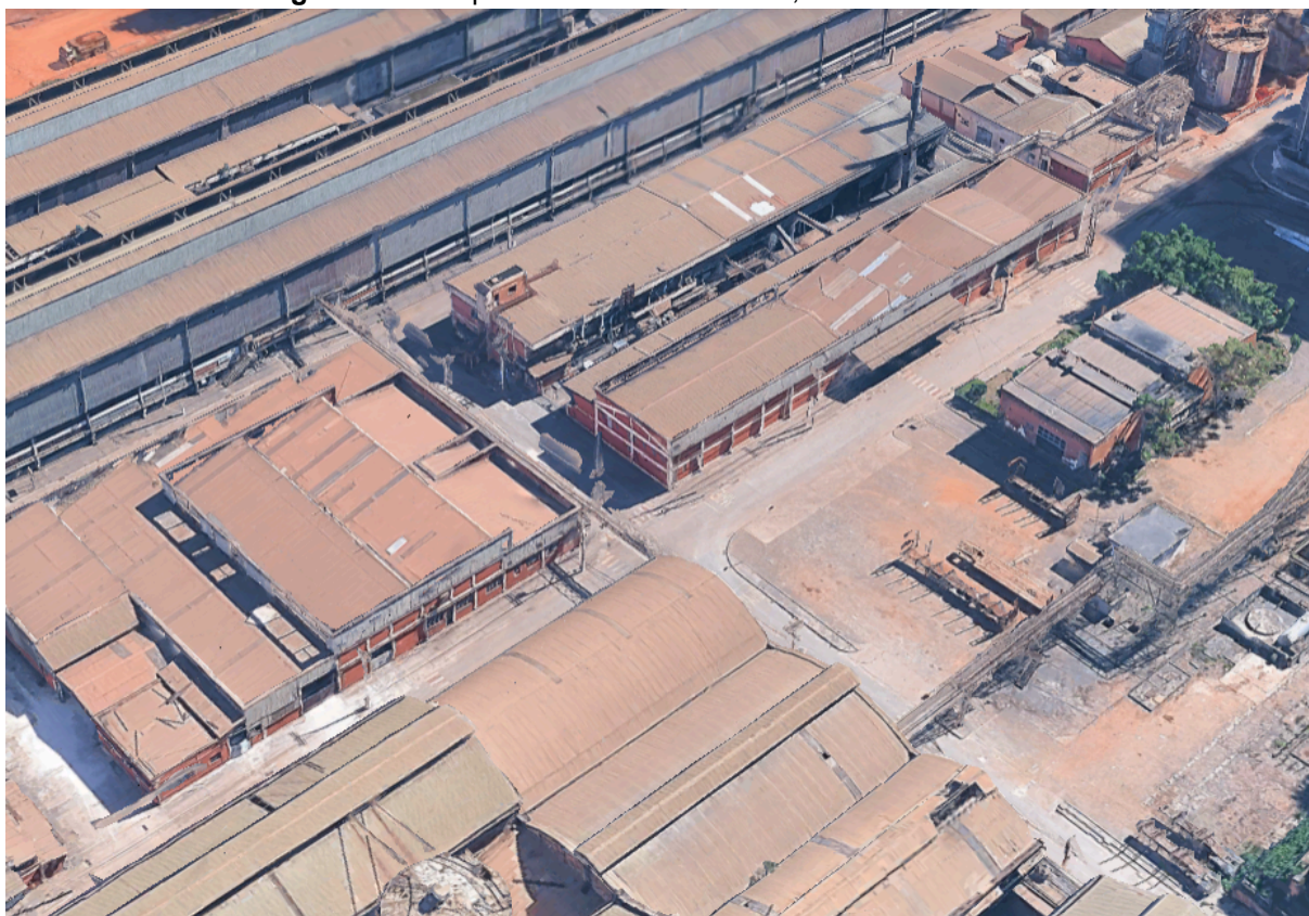
Figura 36: Complexo industrial ACTECH, área administrativa.
