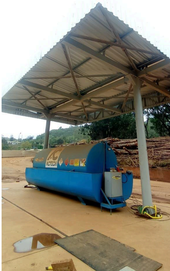
Figura 39: Cobertura metálica leve sobre tanque para abastecimento de veículos.
