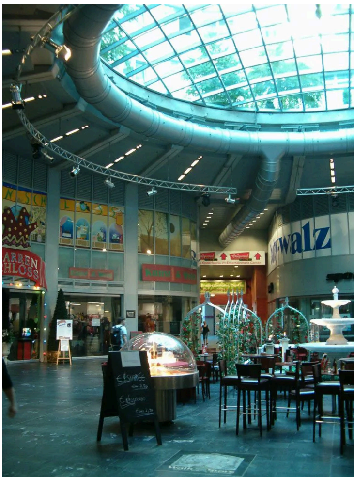
Figura 14 - Gasômetro após intervenções criando espaço comercial.
