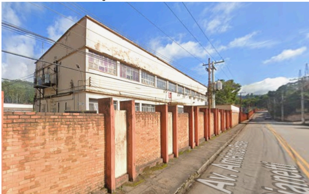
Figura 58: Estudo comparativo antes e depois de intervenção em edificação administrativa às margens da Av. Américo Renê Gianetti.
