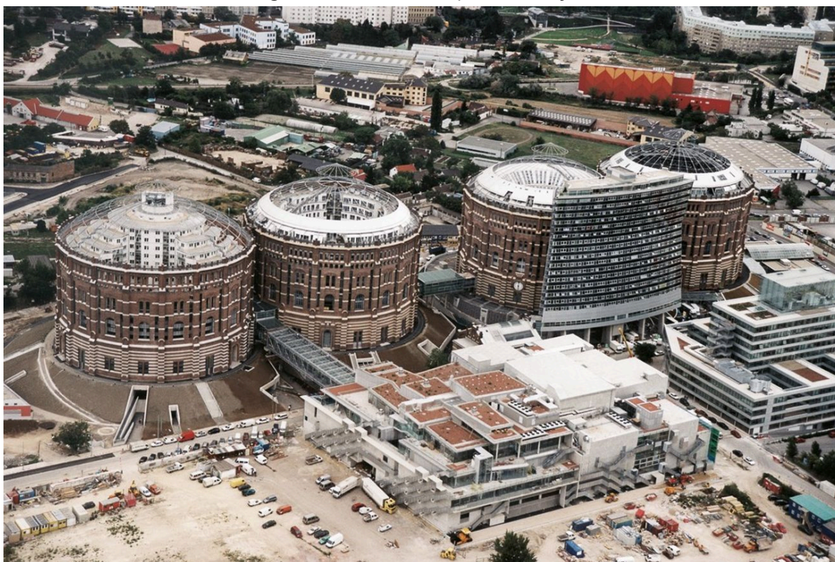
Figura 18 - Gasômetro após intervenção.
