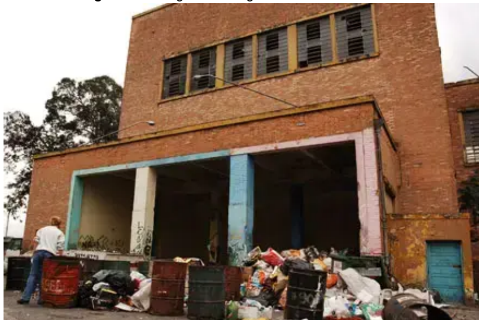
Figura 06 - Imagem do antigo Incinerador Sumidouro.
