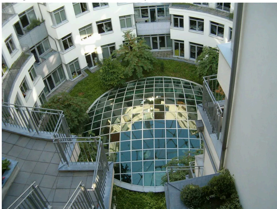
Figura 16 - Gasômetro após intervenções criando unidades residenciais.
