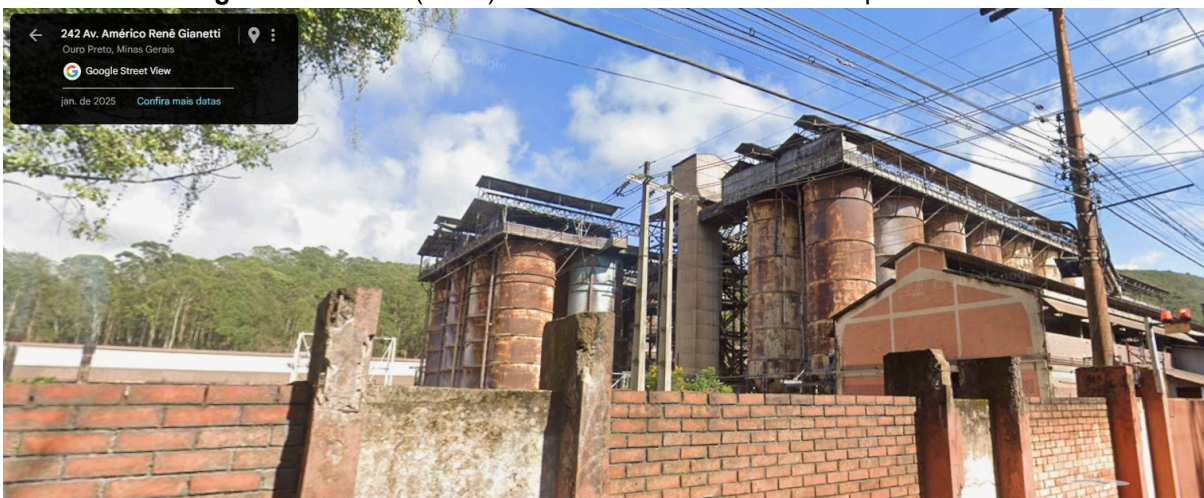
Figura 53: Fase 2 (ciano) - Foto dos elementos a serem preservados.
