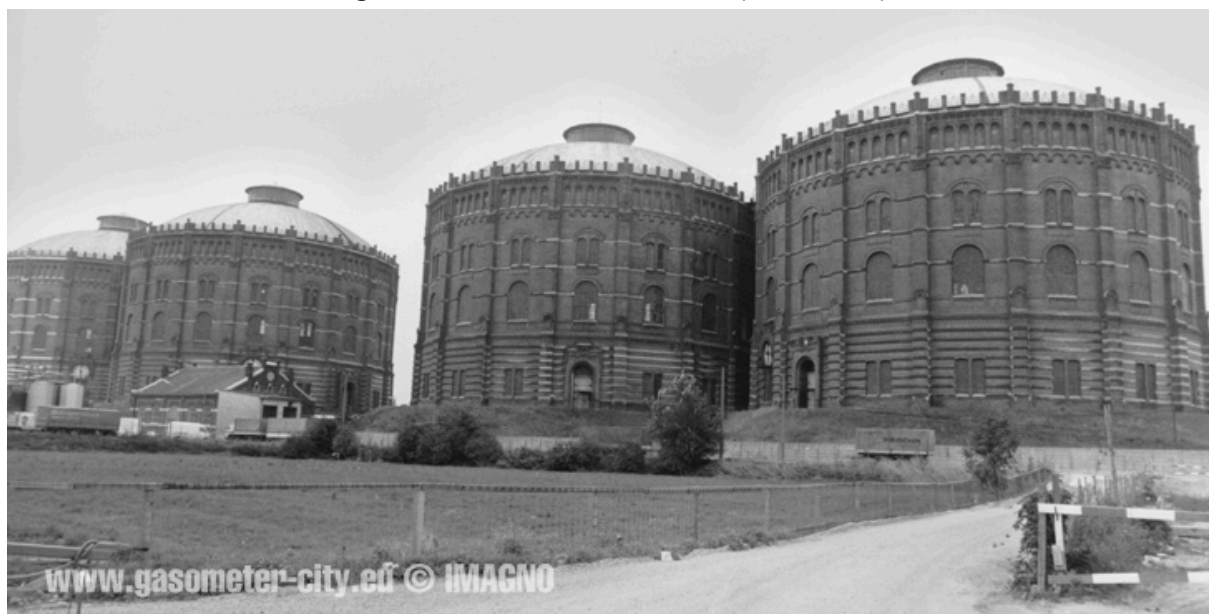
Figura 13 - Gasômetros de Viena (A, B, C e D).
