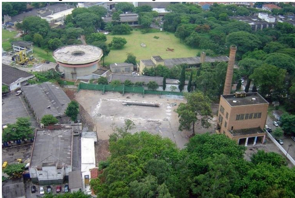
Figura 05 - Imagem do antigo Incinerador Sumidouro.
