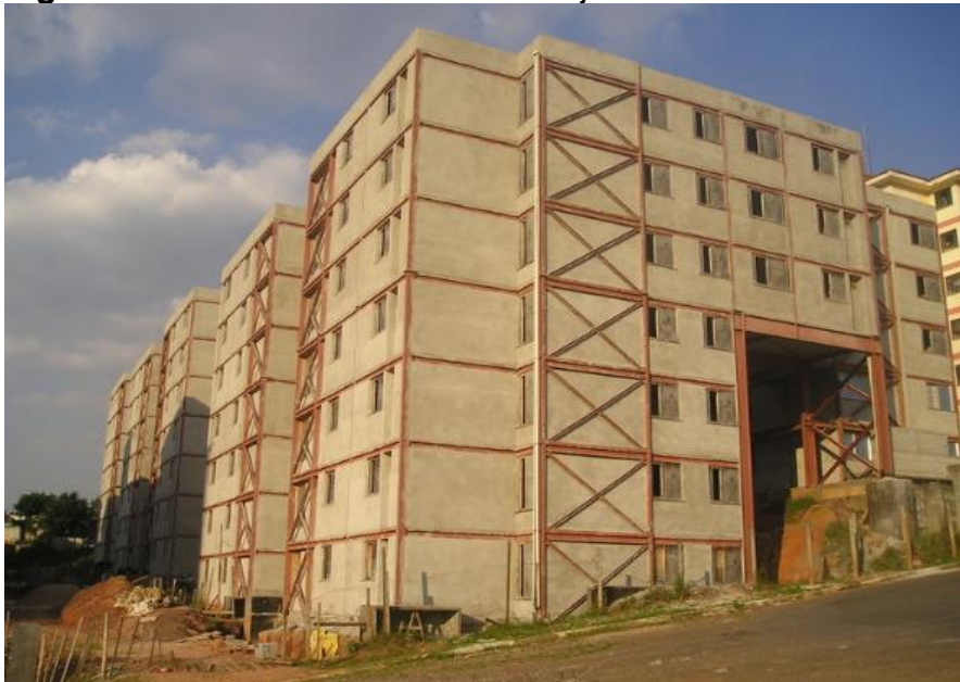
Figura 8 – Estrutura metálica no Conjunto Habitacional Paulo Freire
