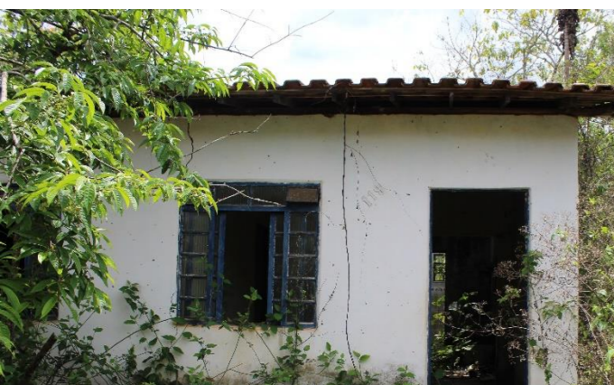
Figura 60: Edificação localizada na parte alta de Bento Rodrigues. Fonte: Julia Ishicava, 2025.
