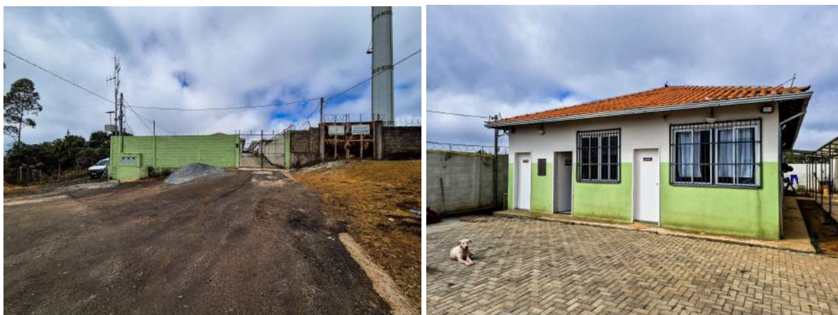
Figura 12: Fachada do Centro de Acolhimento Transitório e Adoção (CATA)
