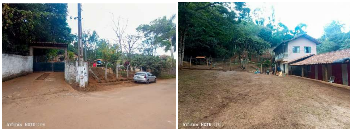
Figura 17: Fachada e Entrada do Resort Pets
