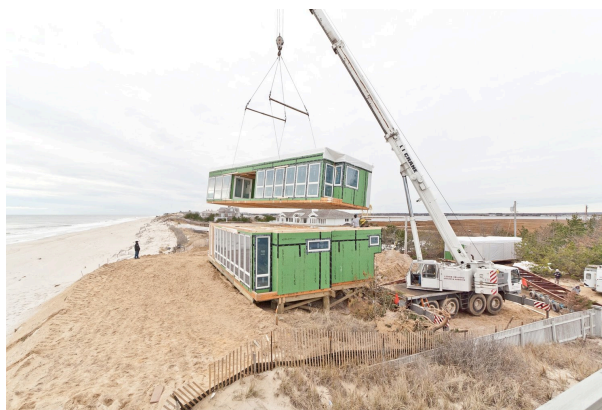
Figura 26 - Instalação de módulo pré-fabricado ( North Fork Bluff House )
