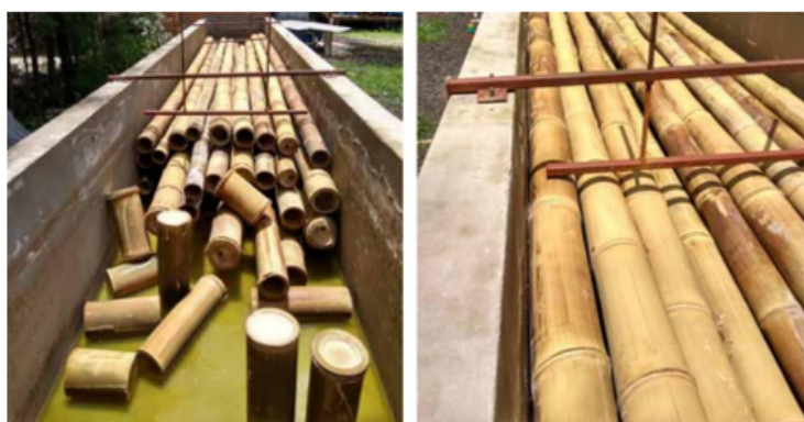
Figura 22 - Reservatório para tratamento de bambu por imersão com uso de bórax e ácido bórico
