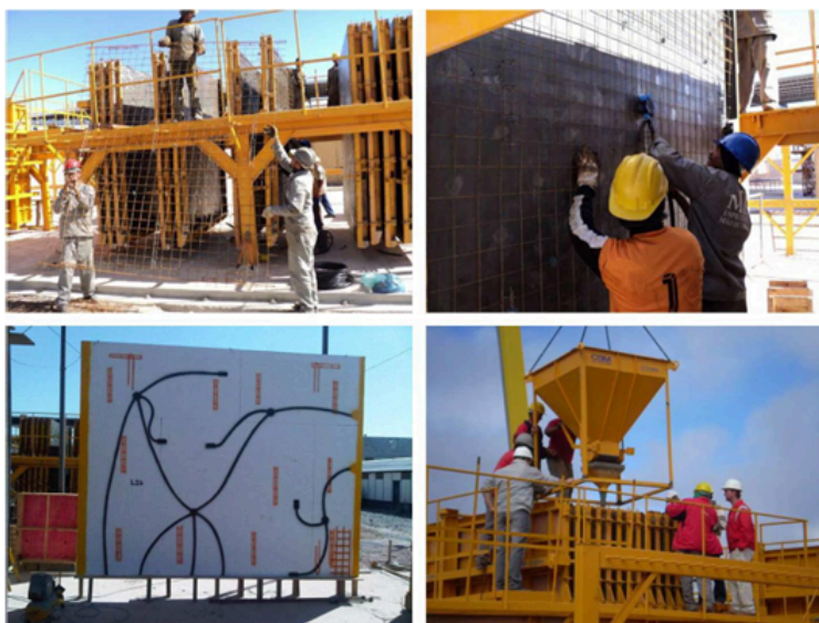
Figura 06 - Pré-fabricação de lajes da Cury Construtora S/A.
