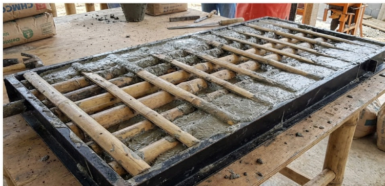
Figura 11 - Painel pré-fabricado de bambu com microconcreto.
