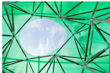
Figura 09 - Estrutura de bambu com seção circular
