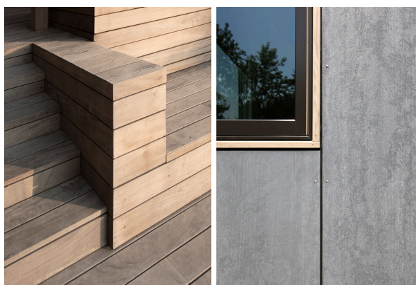
Figura 27 - Detalhes de painéis pré-fabricados de deck e fechamento de fachada na North Fork Bluff House
