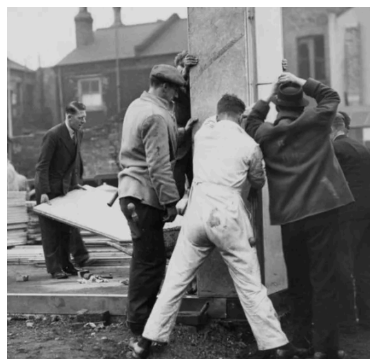
Figura 05 - Construção de pré-fabricados, em Greenwich, 1945.
