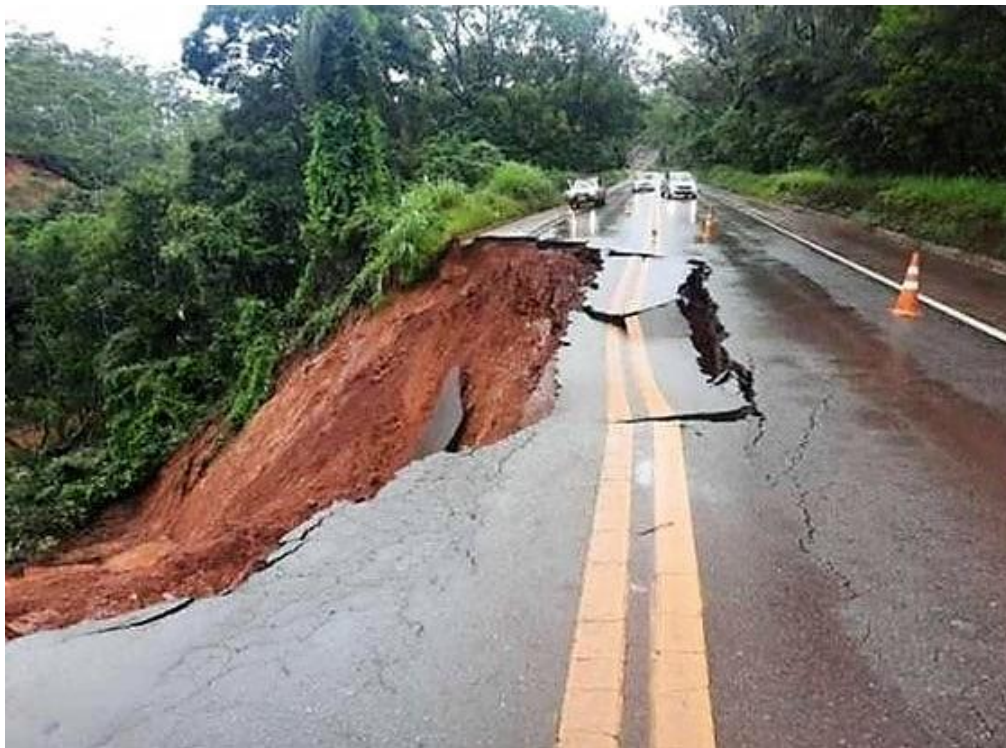
Figura 8 - Processo erosivo no trecho Mariana-Ouro Preto.
