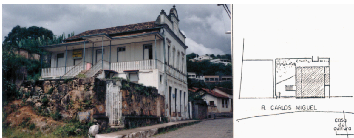
89. Vista lateral direita da CCTI e sua planta de situação (2004)
