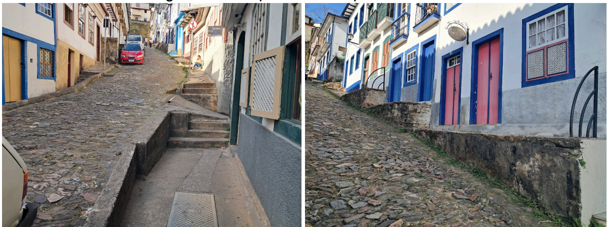
Figura 1 – Trechos de calçada na Rua do Pilar, no centro de Ouro Preto, em que se vê irregularidades que a tornam pouco caminhável.
