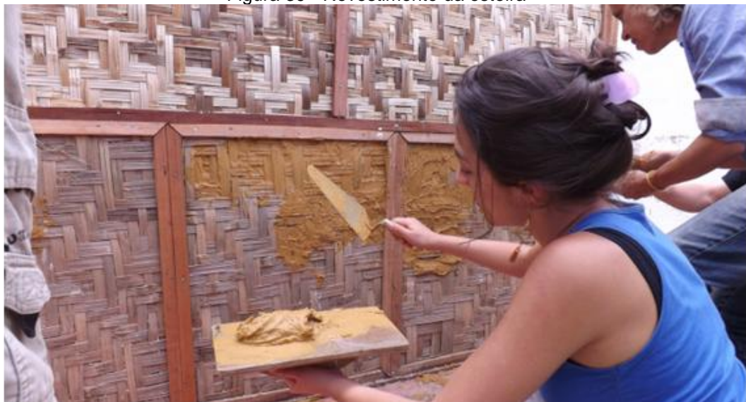
Figura 39 - Revestimento da esteira
