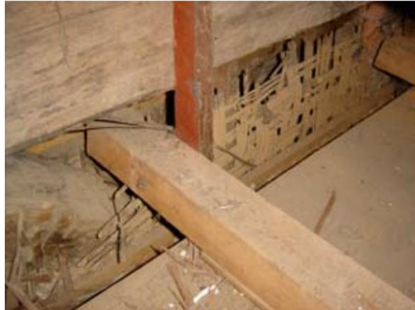
Figura 38 - Detalhe da parte superior da parede de estuque
