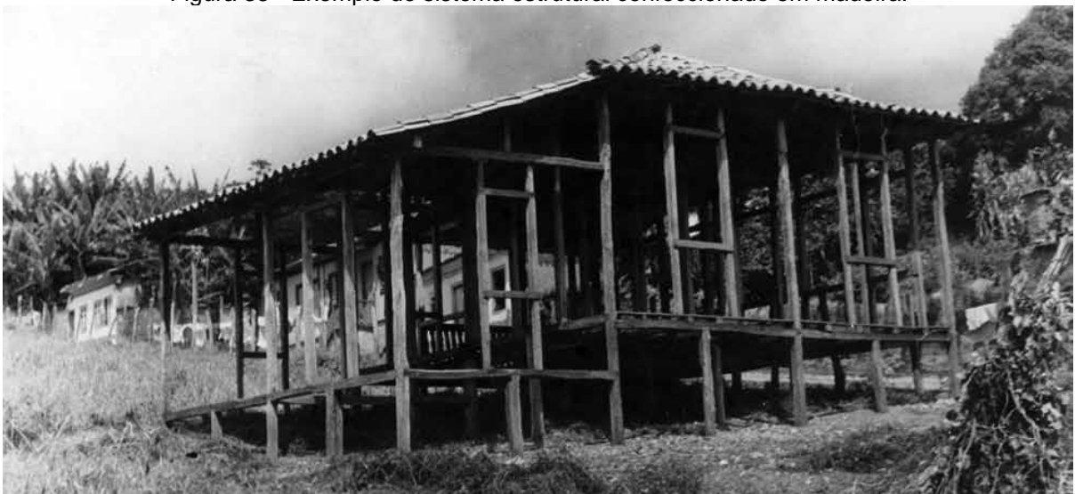
Figura 33 - Exemplo de sistema estrutural confeccionado em madeira.
