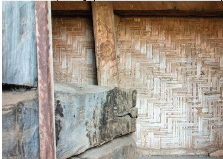
Figura 41 - Parede de estuque na Igreja de Nossa Senhora Rainha dos Anjos, Mariana.
