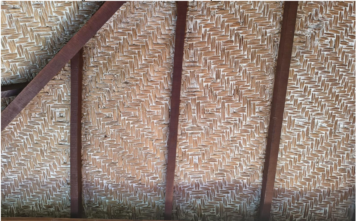
Figura 56 - Forro de esteira com aplicação e massa corrida.
