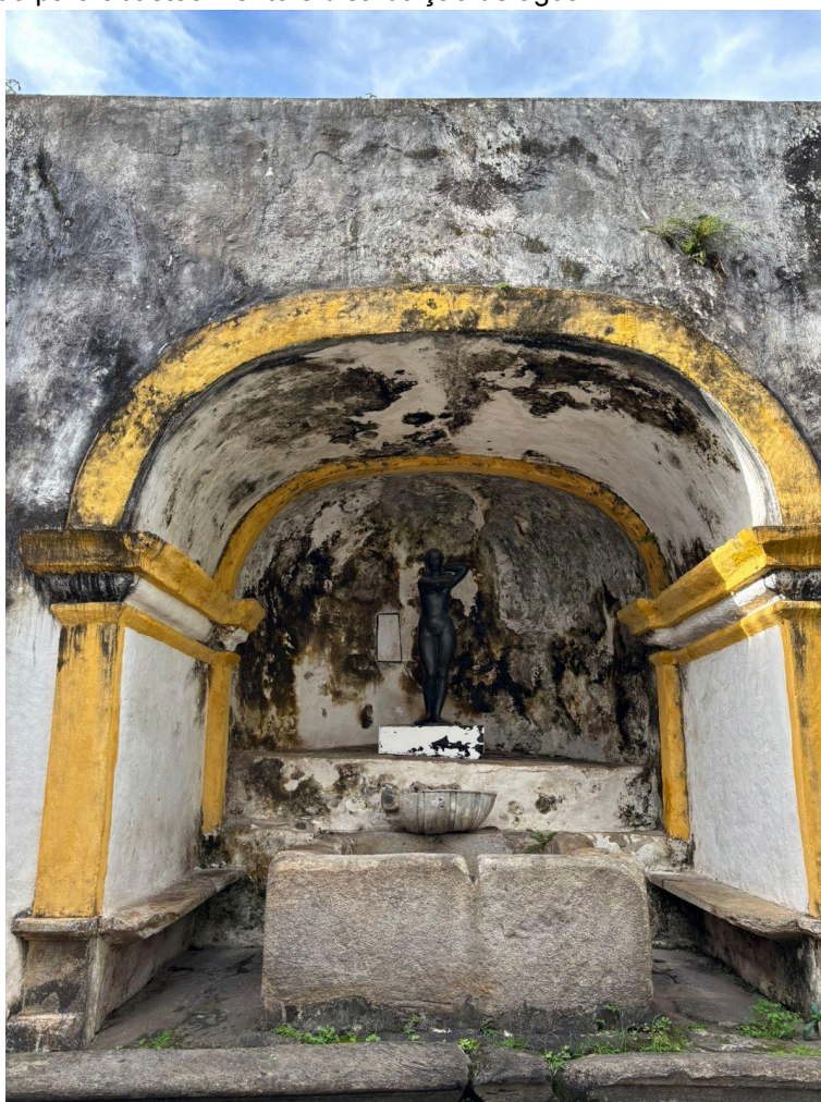
Figura 13: Chafariz interno da Casa Gonzaga, com tanque de pedra-sabão inserido em nicho abobadado, utilizado para abastecimento e distribuição de água.
