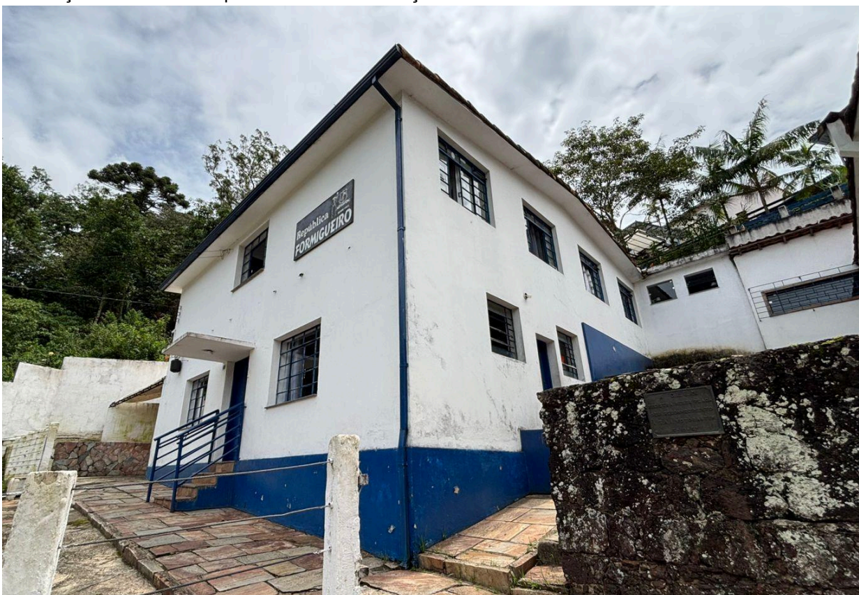
Figura 41: Vista externa da Residência 4. Nota-se o distanciamento das divisas vizinhas e a distribuição das aberturas que favorecem a insolação.
