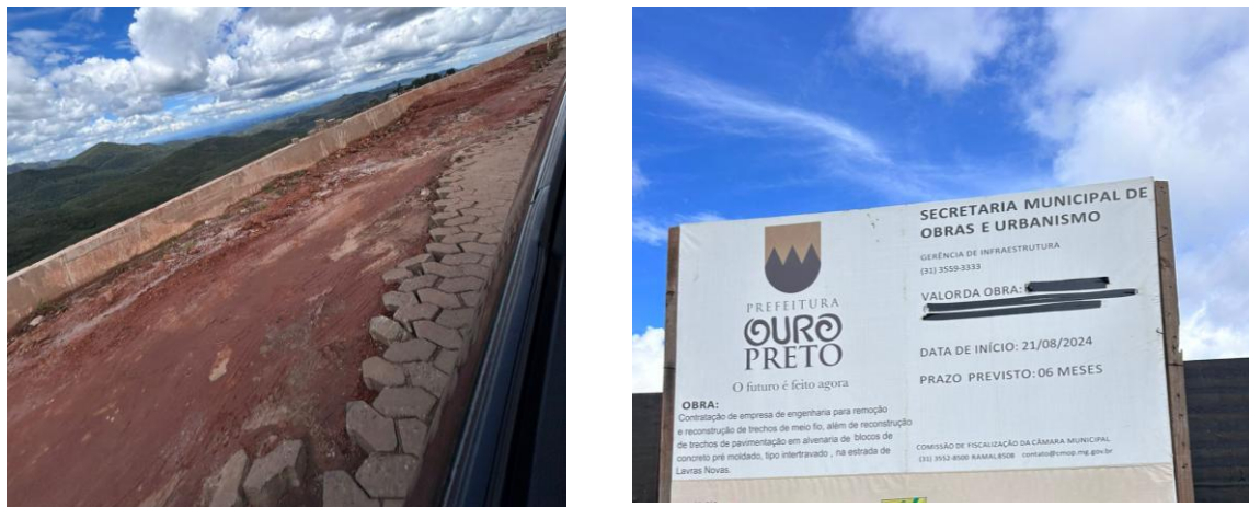
Figura 34: Obras de infraestrutura em Lavras Novas
