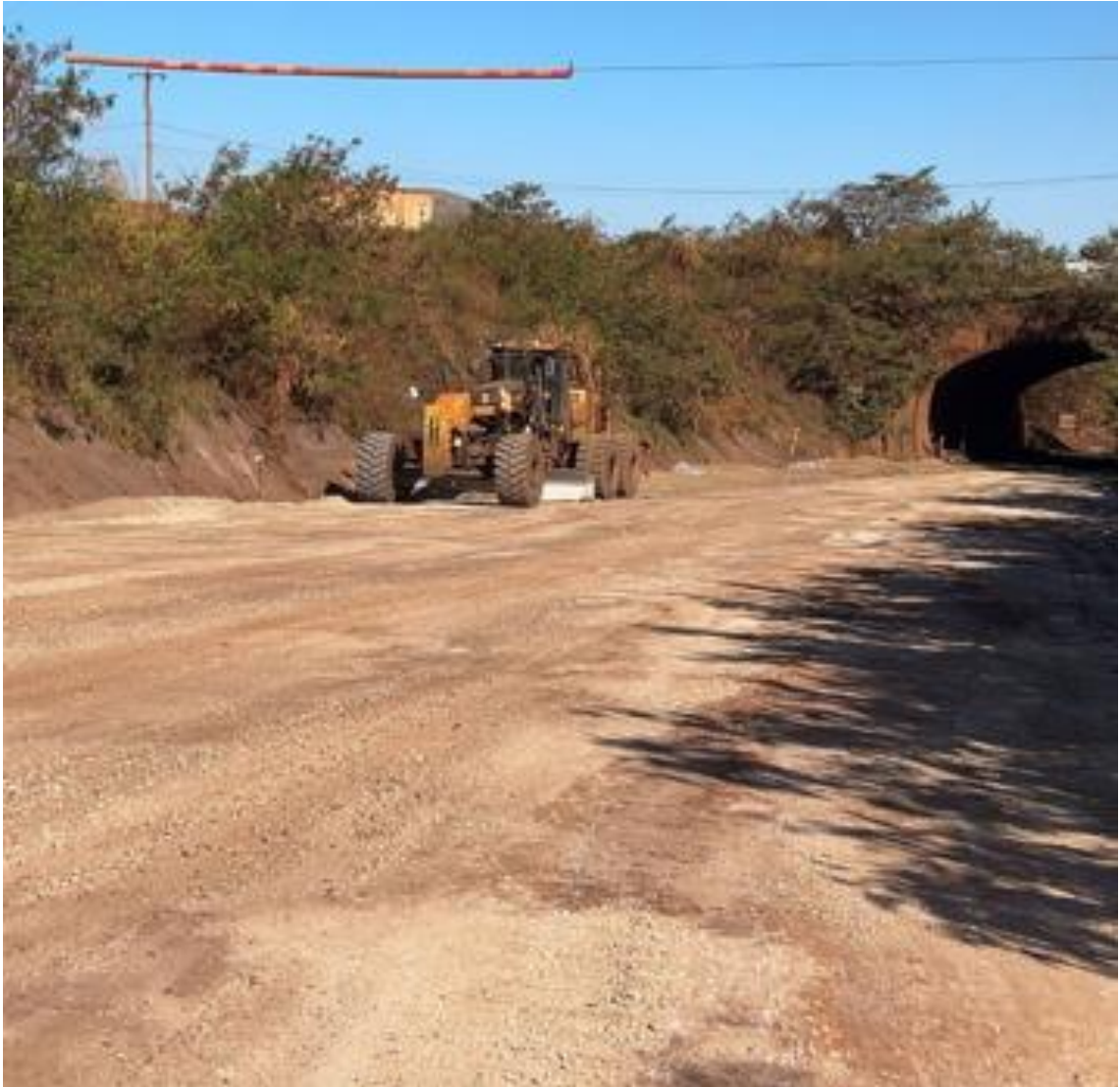
Figura 8 - Espalhamento da camada de blindagem com motoniveladora
