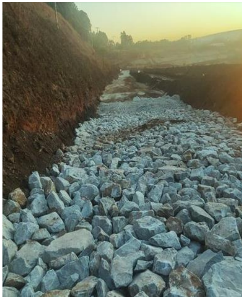
Figura 11 - Espalhamento das camadas de agregados pétreos
