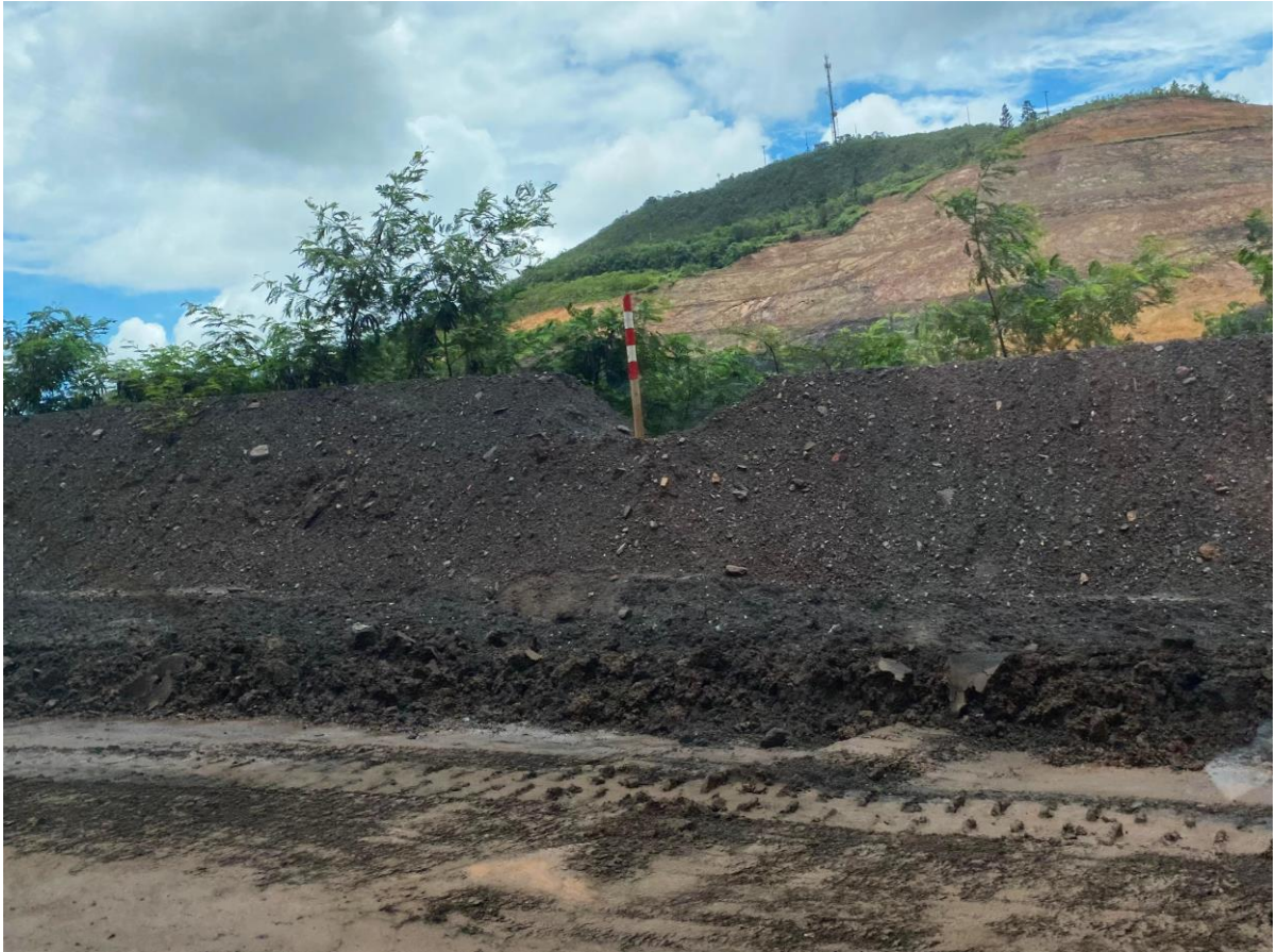
Figura 2 - Leira de proteção em via operacional
