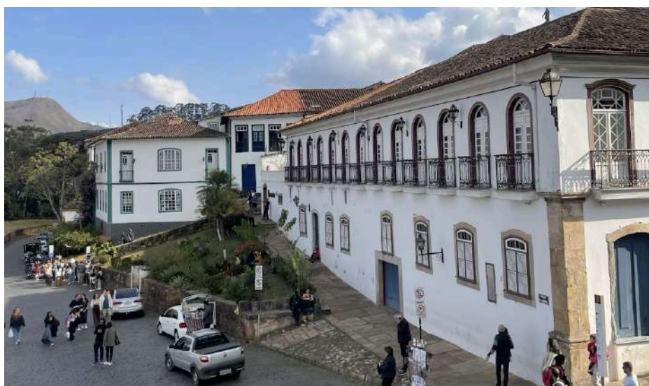
Figura 33: Vista 1 - Edificações no entorno do Largo de Coimbra
