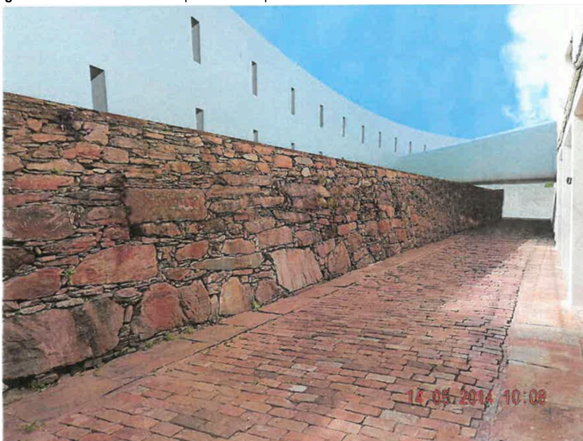
Figura 42 - Muros de arrimo em pedra seca e passarela do Grande Hotel.
