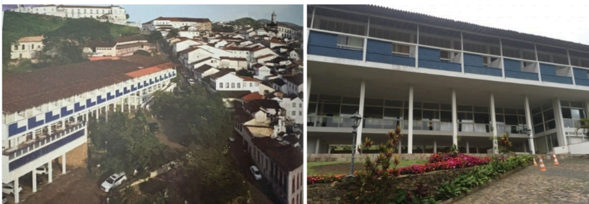
Figura 36 – Fachada do Grande Hotel.
