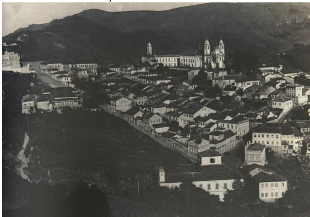
Figura 26 – Terreno antes da construção.
