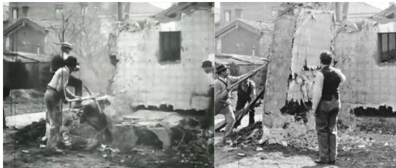
Figura 5. Utilização da montagem reversa em Demolição de um Muro .
