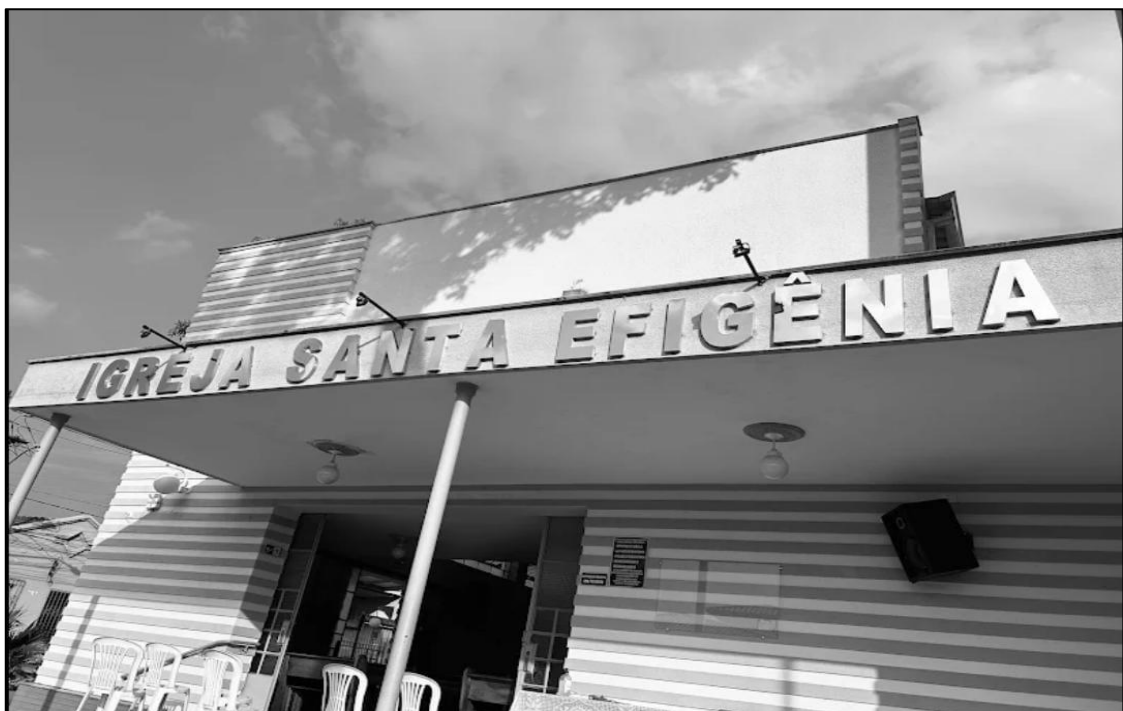
Figura 13 – Fachada Igreja Santa Efigênia, bairro Santa Efigênia (sede, 1959)
