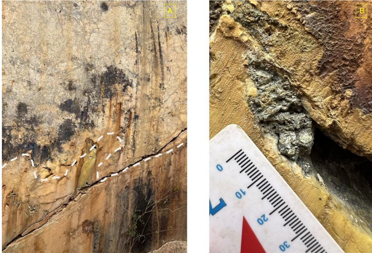
Figura 30 - A: Detalhe de corte do pegmatito do ponto TCC10. A linha branca tracejada separa o núcleo de quartzo (inferior) da zona intermédia do pegmatito (superior). As cavidades miarolíticas aparecem em contato com o núcleo de quartzo, em sua borda ou fraturas em seu interior. B: Detalhe em cristais de pirita encontrados dentro das cavidades miarolíticas do corpo.
