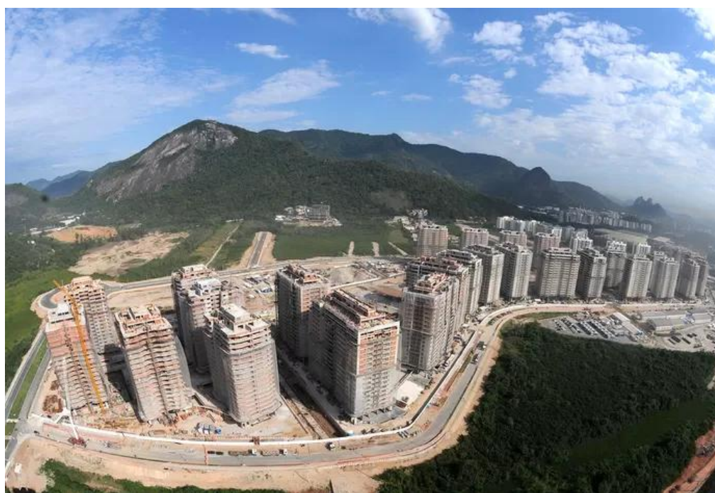
Figura 17 – Vista aérea da Vila dos Atletas em fase de construção.
