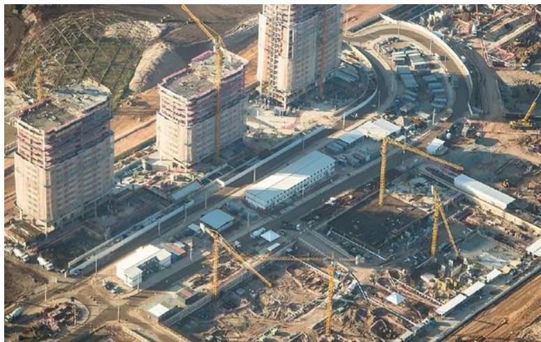
Figura 14 - Vila dos Atletas em fase de construção.
