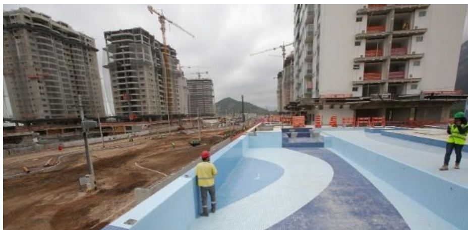
Figura 13 - Vila dos Atletas em fase de construção.
