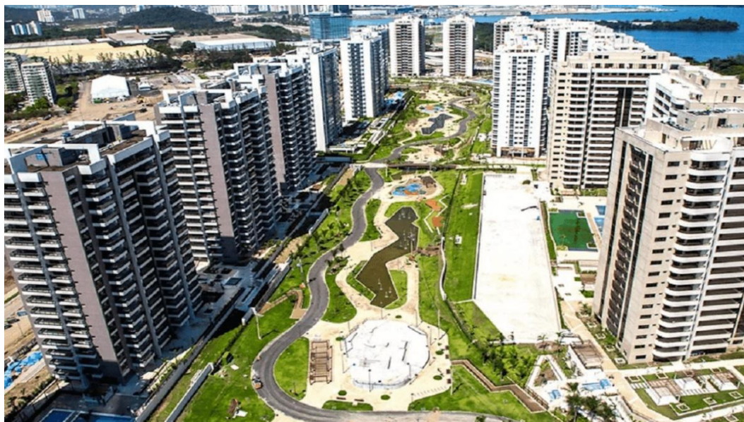
Figura 18 – Vista aérea da Vila dos Atletas após finalização das obras.
