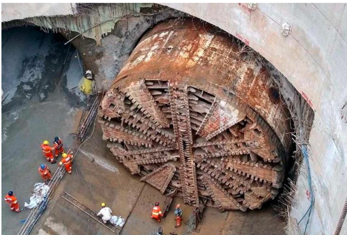
Figura 16 - Tuneladora desembocando em um poço de ventilação
