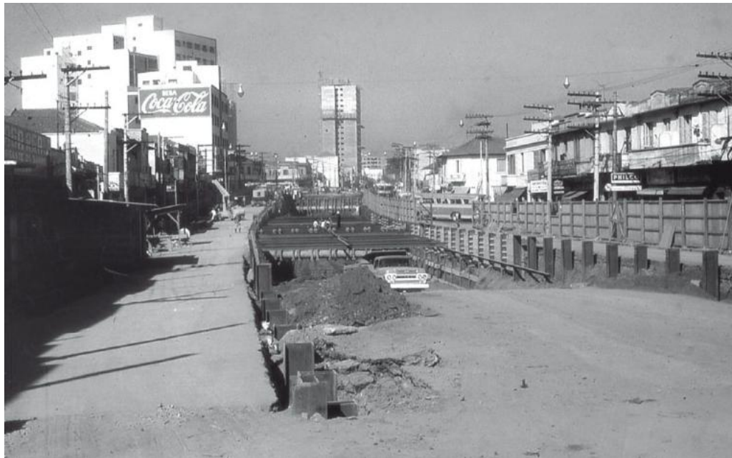
Figura 11 – Construção de túnel pelo método cut-and-cover , na Linha 1 - Azul do Metrô de São Paulo.
