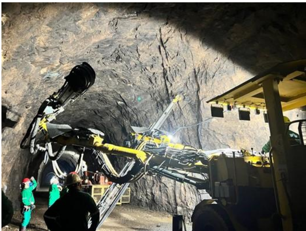
Figura 21 – Aplicação de Tirantes
