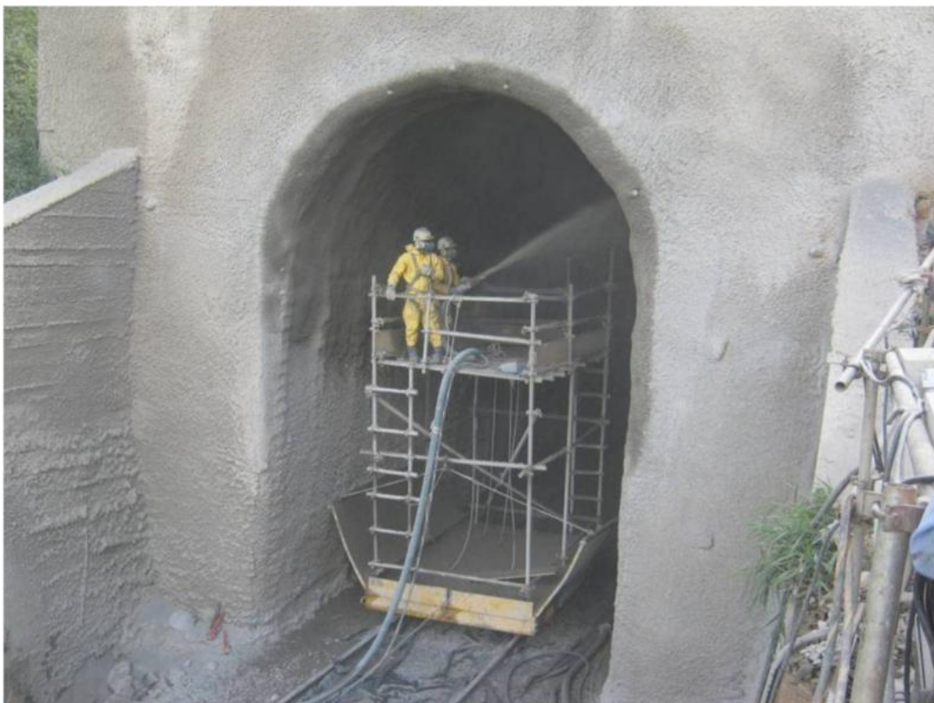
Figura 18 – Aplicação de concreto projetado
