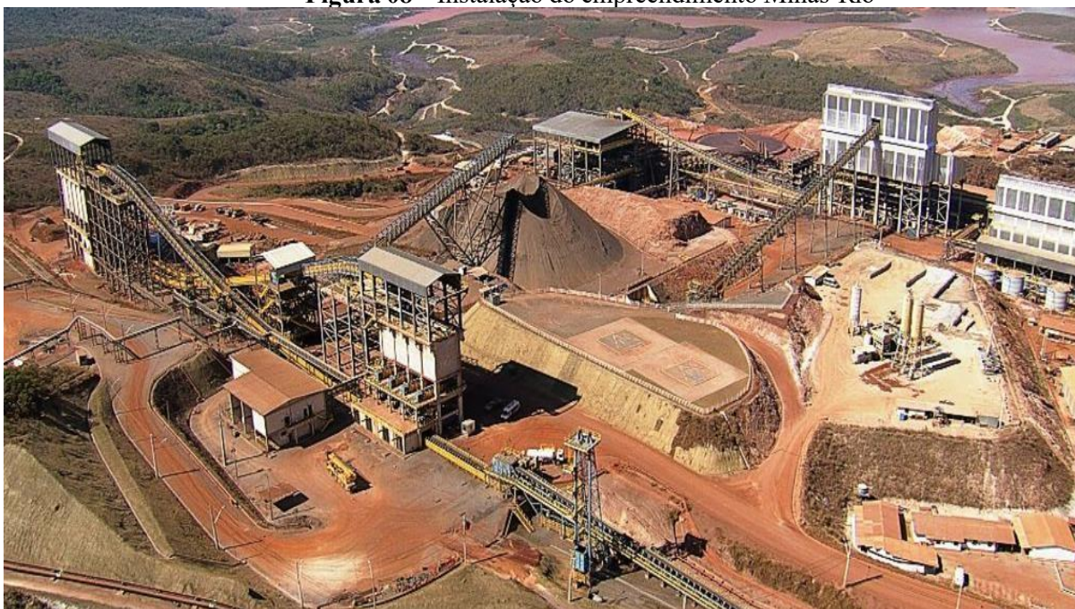
Figura 08 – Instalação do empreendimento Minas-Rio
