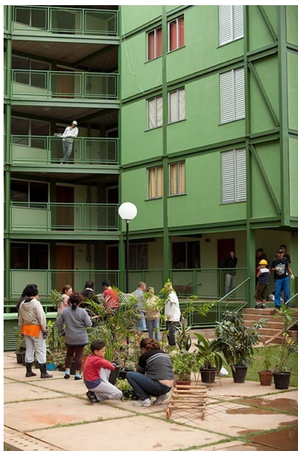
Imagem 17: Área comum do conjunto, já finalizado.
