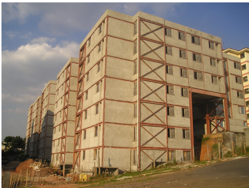
Imagem 16: Esqueleto do prédio pronto, em estrutura metálica e alvenaria de vedação.
