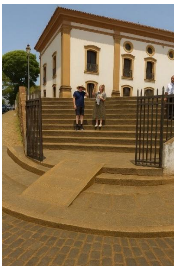
Figura 92 – Rampa associada a degraus na escadaria dos fundos da Igreja de Nossa Senhora do Carmo.
