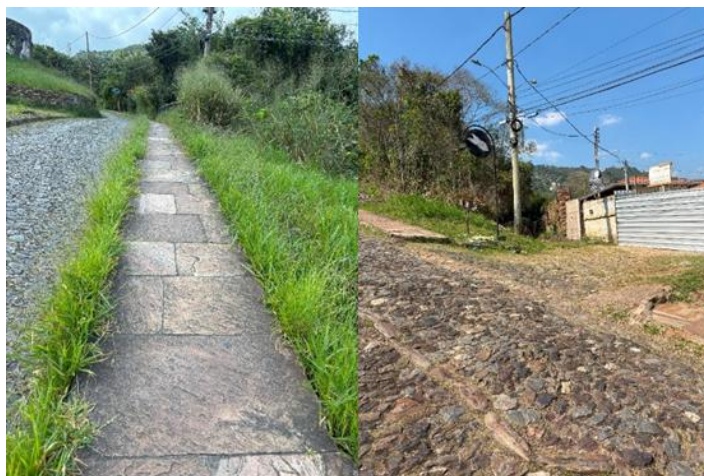
Figura 65 – Desafios à acessibilidade nas calçadas da Rua São Francisco de Paula: (a) vegetação invasora; (b) fragmentação do percurso em cruzamento de ruas.
