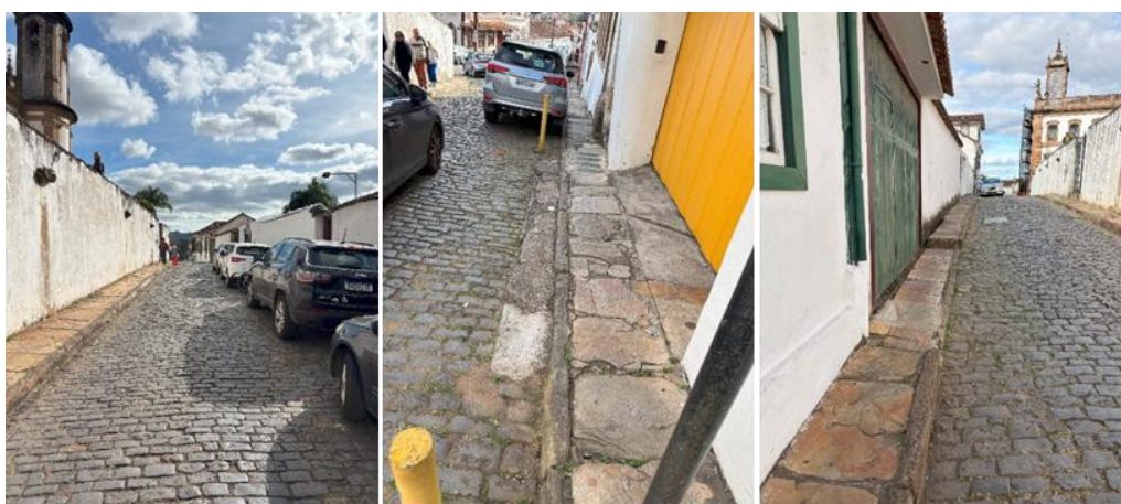
Figura 43 – Via estreita, calçadas desgastadas, postes e rampas privadas na Rua Brigadeiro Musqueira.
