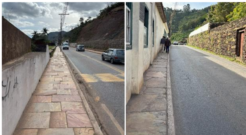
Figura 36 – Dimensionamento inconstante de calçadas na Rua Padre Rolim
