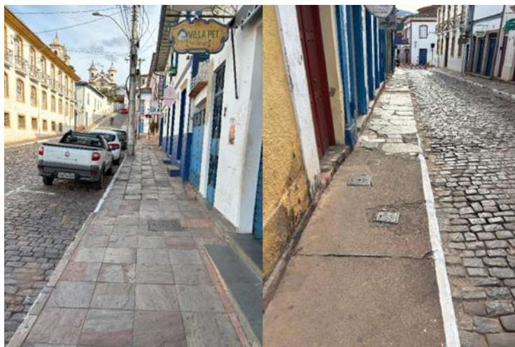
Figura 69 – Calçadas de Mariana: (a) dimensionamento satisfatório e (b) desequilíbrio material.
