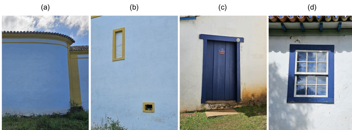
Figura 13 - Detalhes das fachadas laterais. (a) Cordão e cunhal argamassado (ocre) presentes nas duas fachadas laterais, terminando no cunhal e soco de pedra; (b) Vão fechado e abertura sob o presbitério com moldura argamassada e caiada (ocre); (c) Porta (tipo calha) e alisar de madeira em pintura azul colonial e (d) Janela de madeira do tipo guilhotina com quadro e folhas internas cegas, pintadas de azul e caixilhos pintados de branco.
