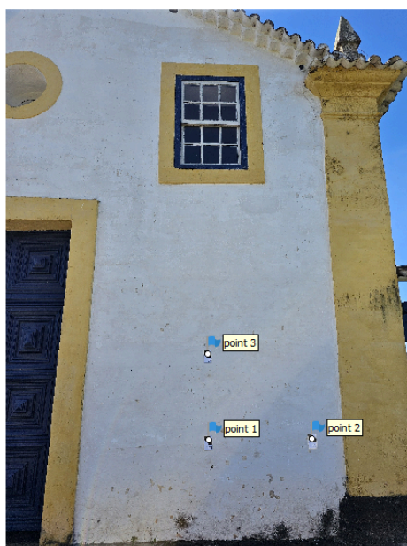
Figura 24 - Marcadores do programa posicionados na fachada frontal, alinhados aos marcadores utilizados no levantamento fotográfico.
