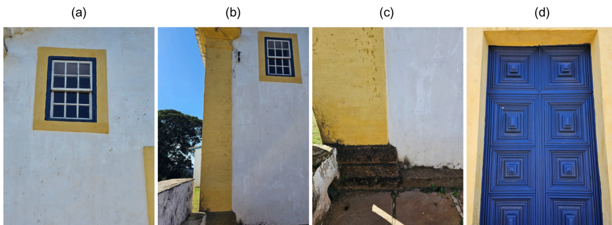
Figura 11 - Detalhes construtivos da fachada frontal da capela. (a) Janela da fachada frontal em alvenaria caiada branca e janela tipo guilhotina com quadro pintado de azul e caixilhos de branco; (b) Cunhal argamassado e caiado (ocre); (c) Soco em pedra; (d) Porta de 2 folhas (ponta de diamante) e pintura azul colonial; (e) Cimalha argamassada e caiada (ocre); (f) Pináculo de pedra; (g) Beiral de beira e bica na cor branca e a cruz cimentada no cume e (h) Portão do adro com os dois pilares de pedra rebocada.
