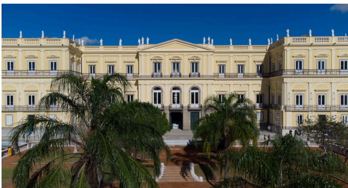
Figura 7: Fachada principal do Museu Nacional após a restauração em 2022.
