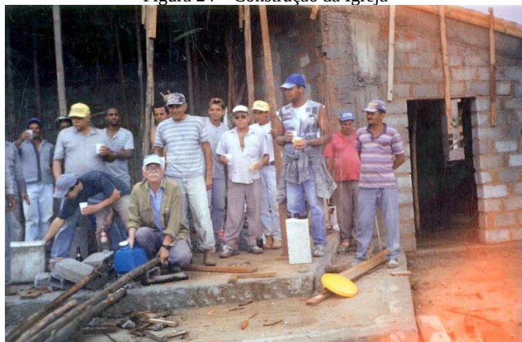
Figura 24 – Construção da Igreja
