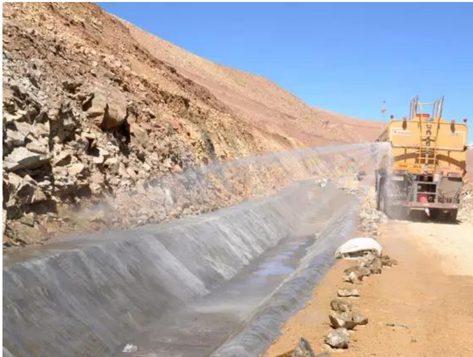
Figura 2 - Vala de drenagem concretada em mina. Fonte: CONCRETO FLEXÍVEL, 2013.
