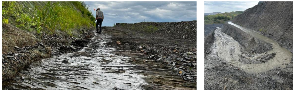
Figura 14 - Verificação do escoamento da água em rampas de drenagem durante a estação chuvosa. Fonte: AZEVEDO et al. , 2024.
