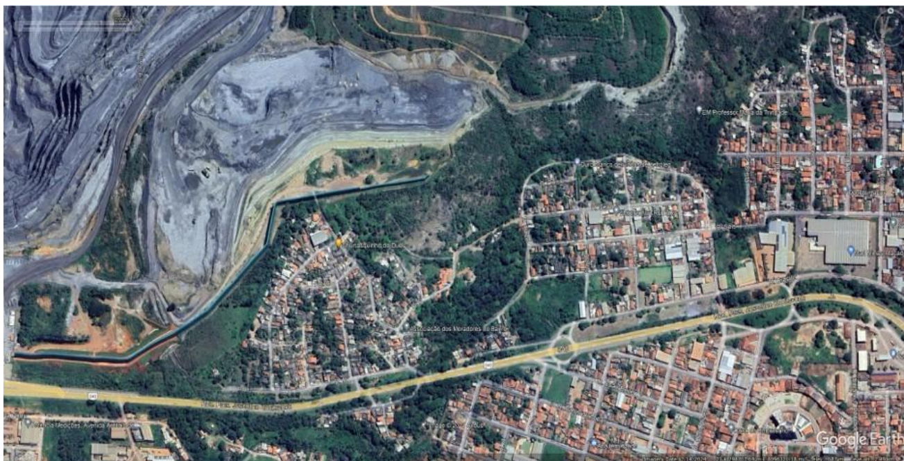
Figura 6 - Vista aérea da mina de Morro do Ouro, destacando a proximidade do pit de lavra com a comunidade adjacente. Fonte: AZEVEDO et al. , 2024.
