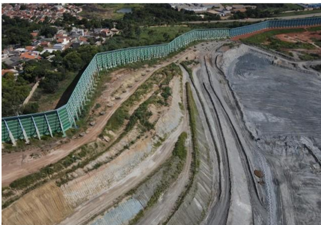
Figura 19 - Crescimento da vegetação nas bancadas saprolíticas após a hidrossemeadura. Fonte: AZEVEDO et al. , 2024.
