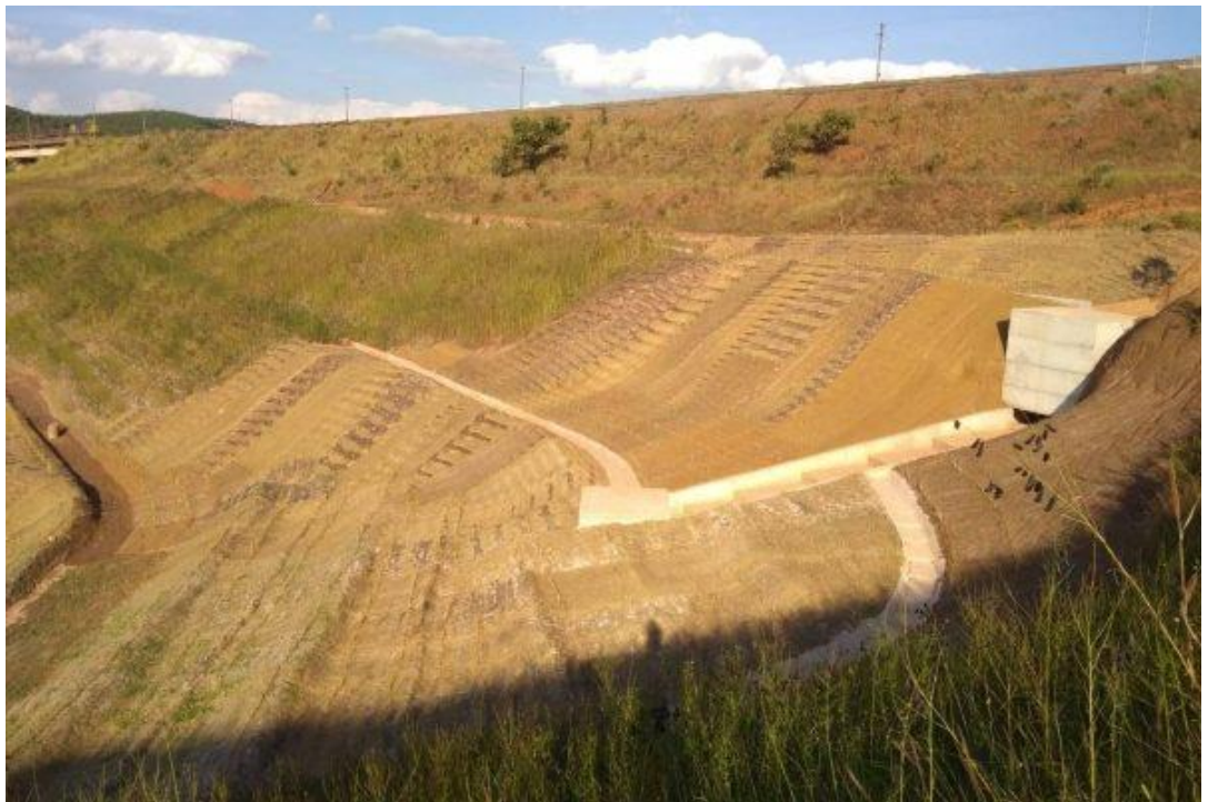
Figura 4 - Escada hidráulica de dissipação de energia. Fonte: TERRA GREEN, 2025.
